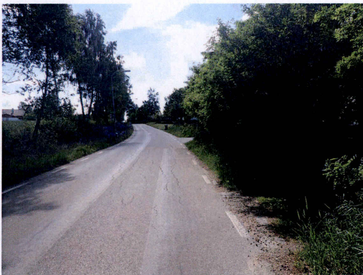
Figur 14 Väg 1680 mellan vattentäkt och Långhem samhälle, sedd mot norr (Foto: Ramböll, 2017).
