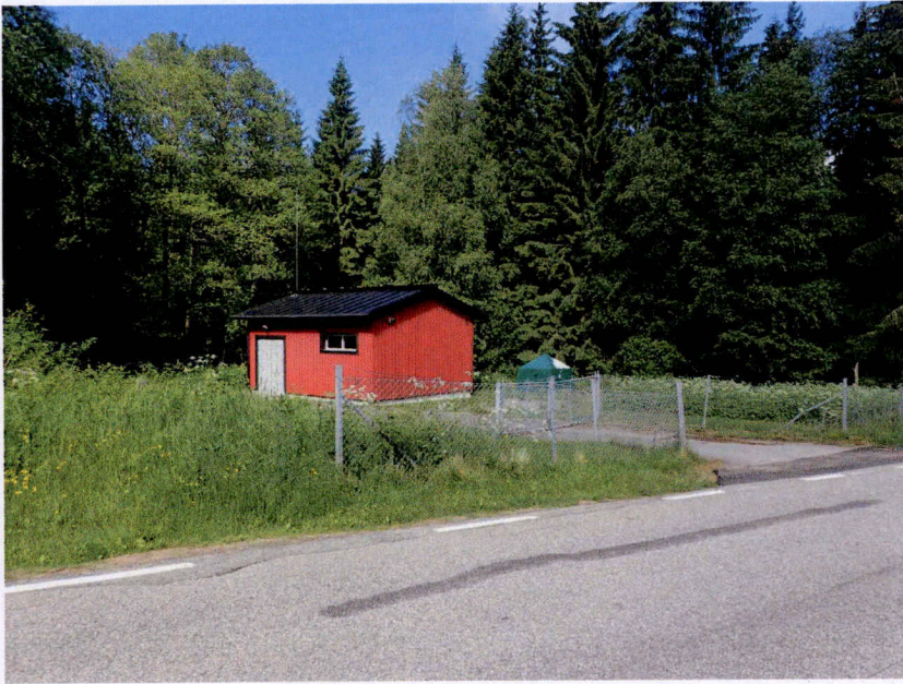
Figur 5 Långhem vattentäkt utmed väg 1680 med en av uttagsbrunnarna (grön brunnsöverbyggnad) och vattenverk (röd byggnad) (Foto: Ramböll, 2017).
