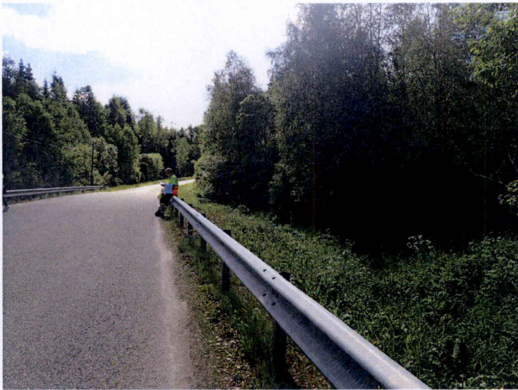
Figur 16 Passage över bäck på bank och med skyddsräcken vid sidor av vägen, sedd mot söder (Foto: Ramböll, 2017).
