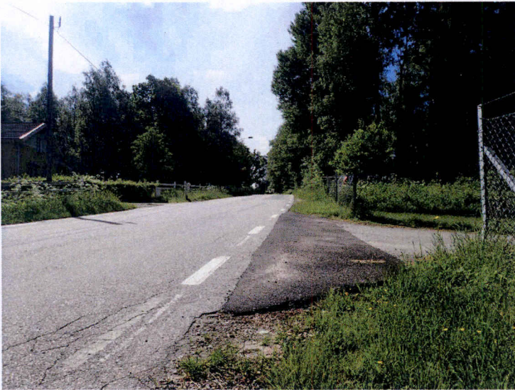
Figur 15 Infart till vattentäkt från väg 1680, sedd mot söder (Foto: Ramböll, 2017).
