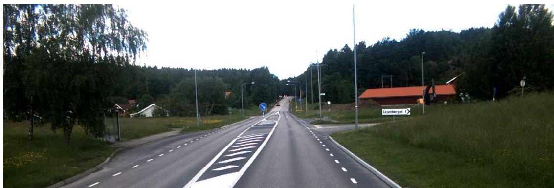
Figur 7. Exempel på utformning av målad mittrefug längs västra delen av väg 180 inom utredningsområdet. Foto: Trafikverket.
