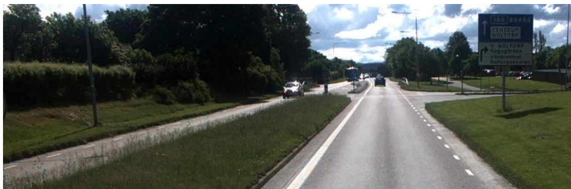
Figur 6. Exempel på utformning av mittrefug med kantsten längs väg 180 inom utredningsområdet. Foto: Trafikverket.
