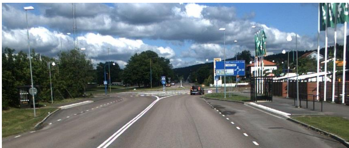
Figur 24. Hållplats Alströmmervallen är tillgänglighetsanpassad. Foto: Trafikverket.
