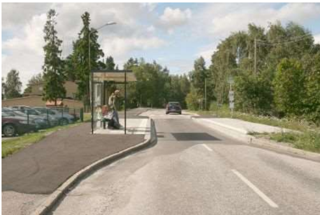
Figur 11-8. Exempel på busklack (timglashållplats) från Eskilstuna.
