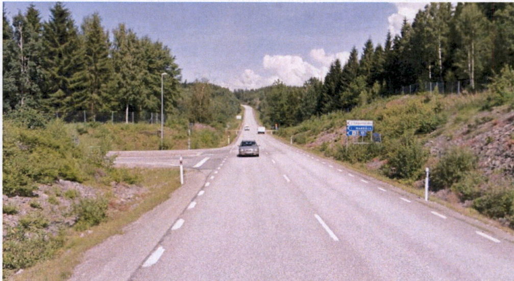
Figur 2 Väg 157 mot norr, norra korsningspunkten med väg 1715 (foto: Google Maps).
