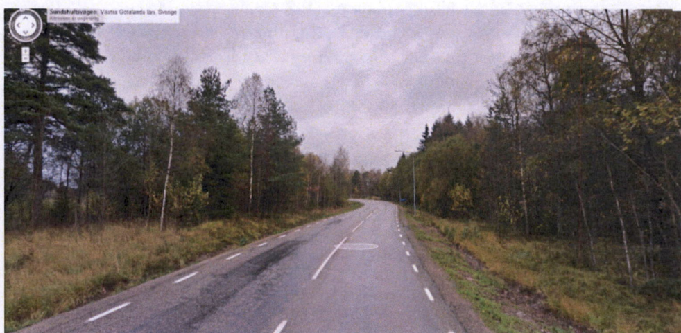
Figur 5 Väg 1762. (Foto: Google maps)
