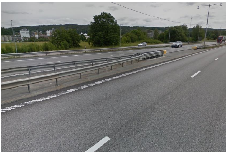
Figur 21 Exempel på samordnad överledningsplats och katastroföverfart
