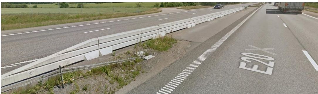
Figur 22 Exempel på samordnad överledningsplats och katastroföverfart
