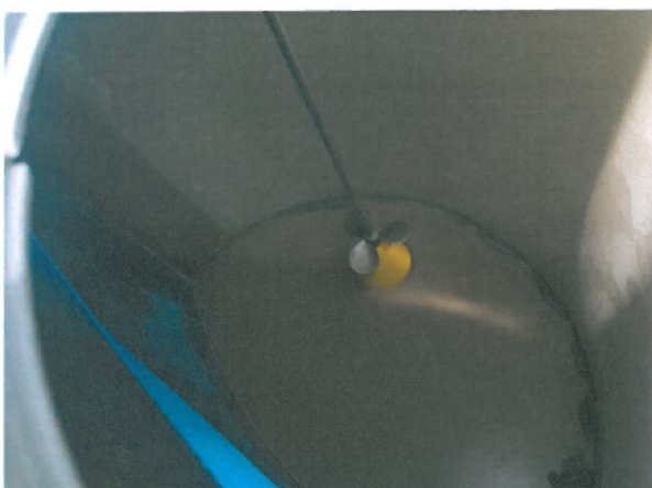
Figur 28. Snabbomrörare för koagulant i separat del av tank (bildkälla: Högsbo dagvattenrening).
