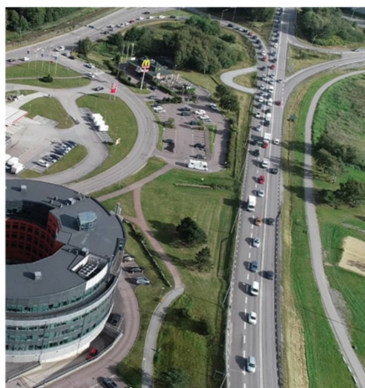
Figur 3. Utklipp av situation för vävningssträckan på Väg 160 under rusningstrafik
