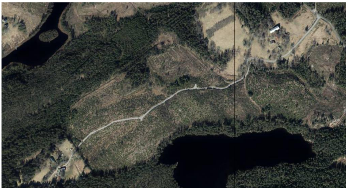
Figur 27. Flygfoto (2018) över befintlig skogsbilväg mellan Östtorp och Lunden, Vårgårda kommun.
