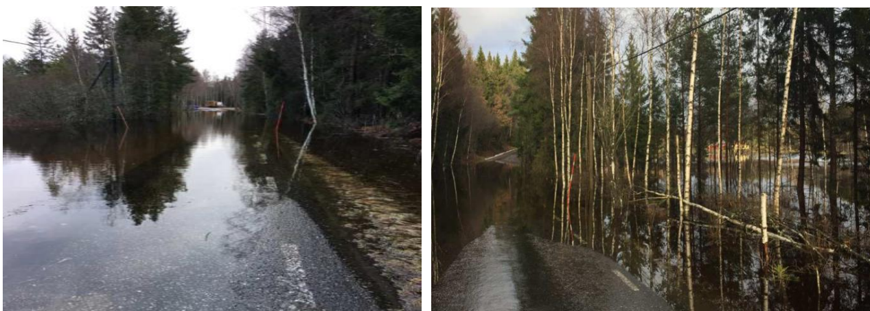
Figur 2. Översvämmade partier av Lygnövägen. Foto: Trafikverket.
