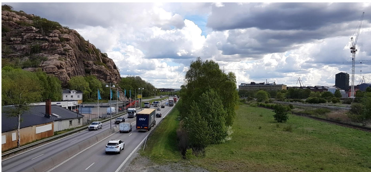
Figur 4. Lundbyleden och Hamnbanan vid Ramberget. Foto taget mot öster.
