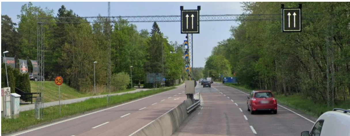
Figur 28: Exempel från Värmdöleden, övergång från 2+2 körfält till trefältsväg med reversibel indelning.
