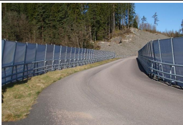
Bild 5. E45, vid Alafors finns en breddad konventionell bro med skärmar samt gräsyta intill ena kanten av bron.
