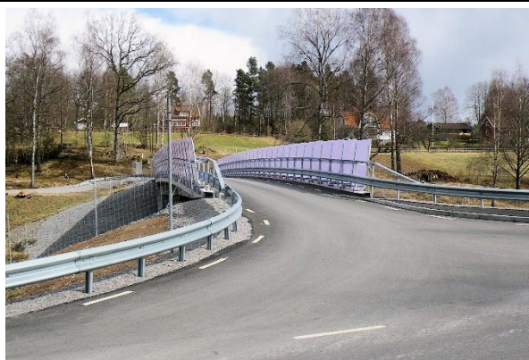
Bild 6. E20, bro för enskild väg med skärmar, söder om Alingsås. Skärmarna får i detta sammanhang ses som en ytterst begränsad anpassning för faunan.
