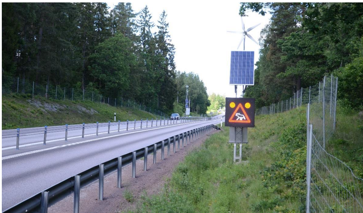
Figur 32: VMS-skyltar med t ex älgsymbol ska aktiveras när vilt är i faunapassagen och därmed varna bilister. Foto från Haraldsmåla E22, faunapassagen ligger ca 250 m bortanför VMS-skylden. Foto: Mattias Olsson.
