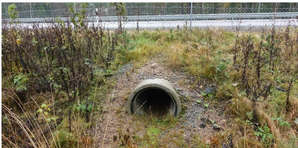
Figur 6. Faunastängsel och torrtrumma under E20 vid Risa-Arentorp, Vara.
