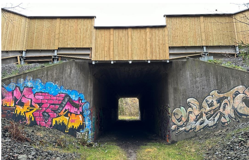
Figur 7. Vägport förstärkt med ljus- och bullerskydd, väg 40, Månstorpet, Mölndal.
