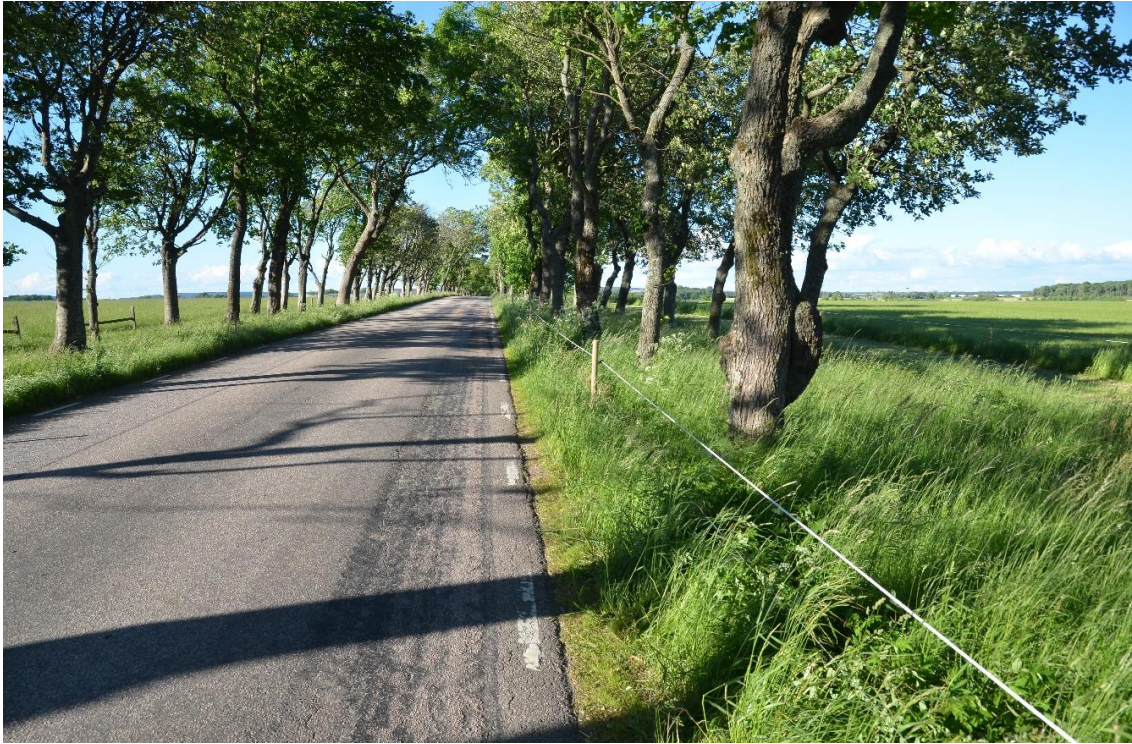
Figur 4. Dubbelallé vid Vapnö, väg N611, Halmstad.
