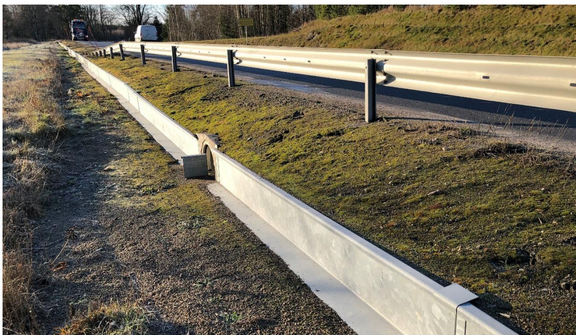
Figur 8. Ledarmar och torrtrumma för grod- och kräldjur, vid väg O697, Ässet, Vänersborg.
