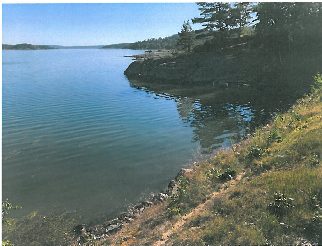
Figur 33. Vägbank över mittendelen av sundet Orust – Lilla Askerön. Bild tagen på norra sidan av vägbanken, vy mot nordost.
