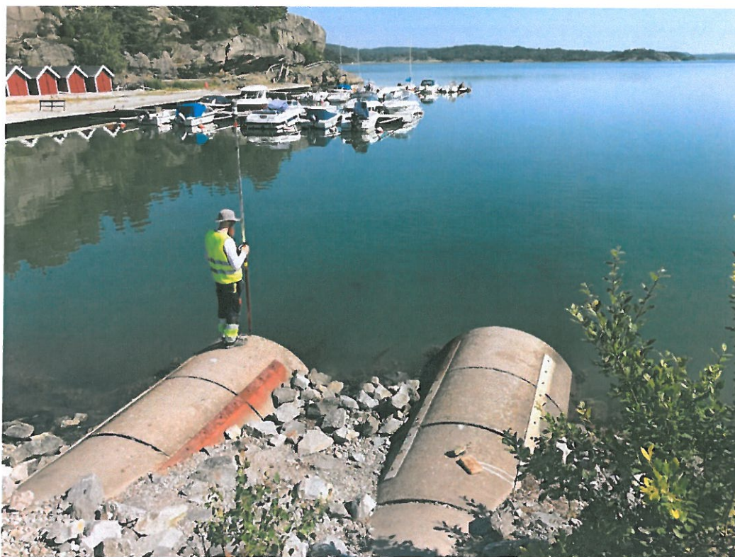
Figur 34. Vägbank med trummor i västra delen av sundet Orust – Lilla Askerön. Bilden är tagen på norra sidan av vägbanken med vy mot norr.
