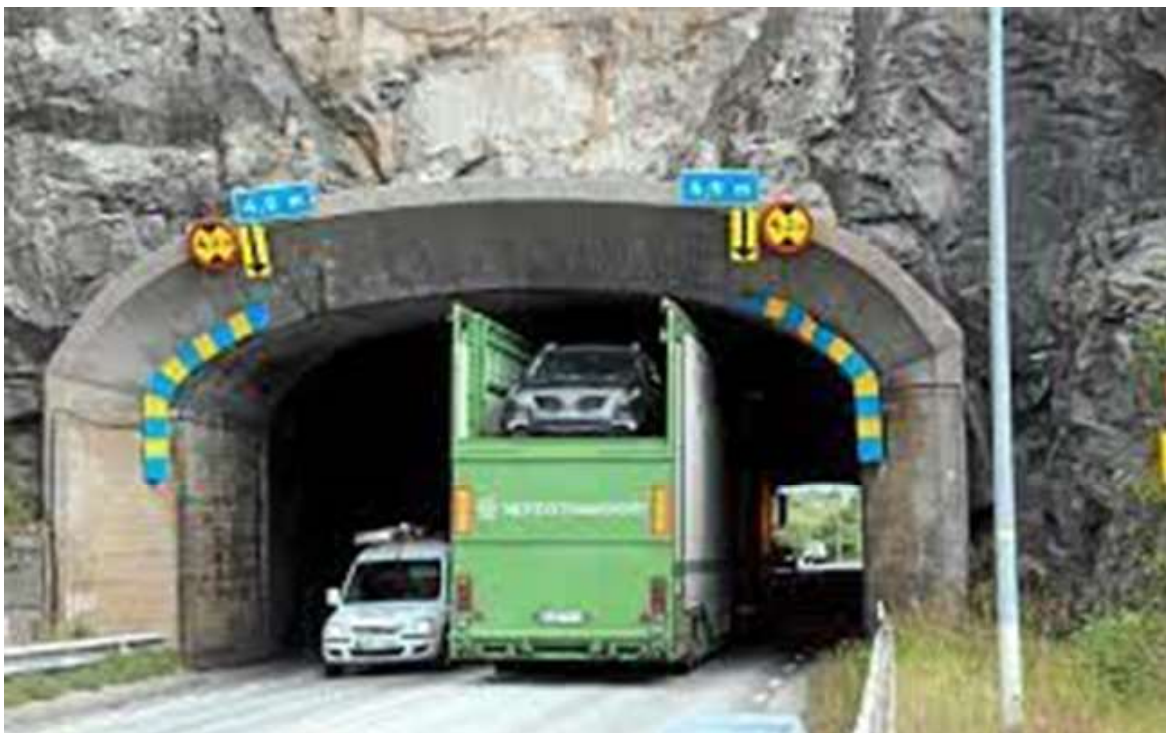
Figur 38. Höga transporter måste hålla sig nära mittlinjen av Stenungsötunneln för att kunna passera fritt, dock inte passera över den. (Foto: Hanna Strömbom)
