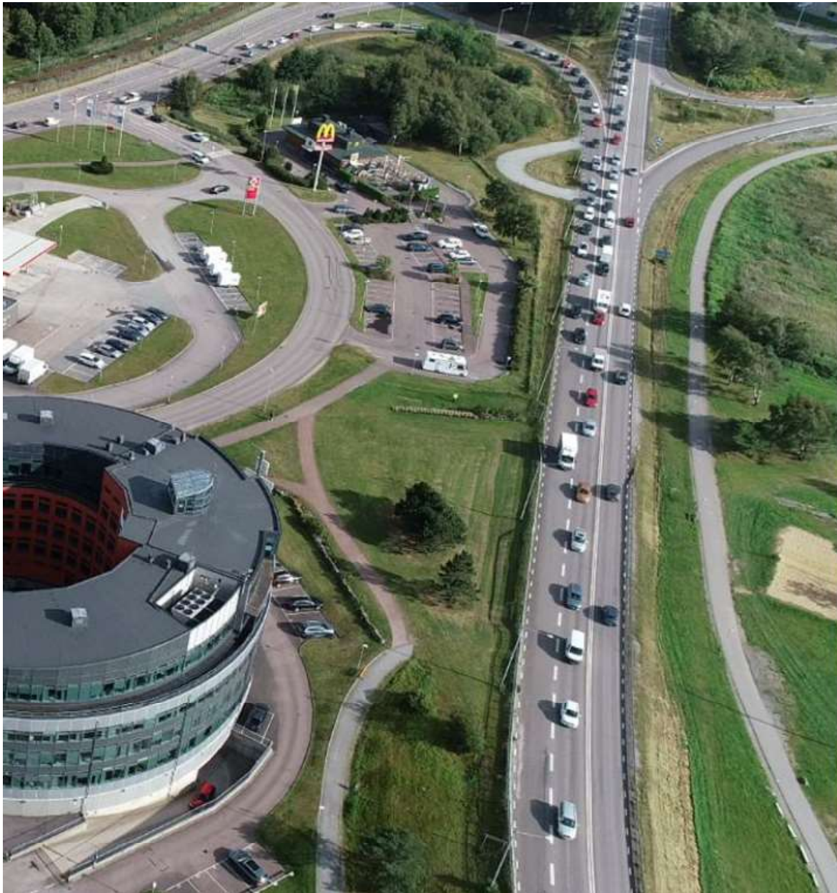
Figur 19. Drönbild från västra delen av Nösnermotet som visar sammanvävningen närmast före Stenungsöbron, vilken är en flaskhals i och med att det bara finns ett (1) körfält vidare ut mot Öarna. (Källa: Trafikverket 2022a)
