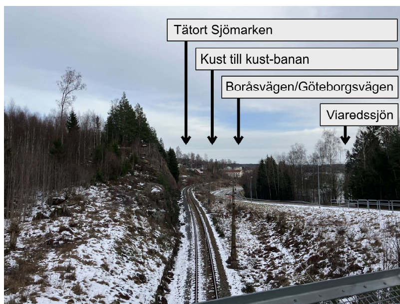
Figur 24. Bild på Kust till kust-banan vid Sjömarken. Fotografi Trafikverket (2023-02-10).
