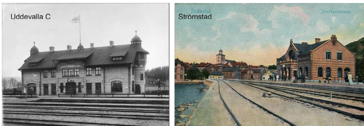
Figur 6. Uddevalla och Strömstad stationshus. Bildkälla: järnvägmuseet ( digitaltmuseum.se )
