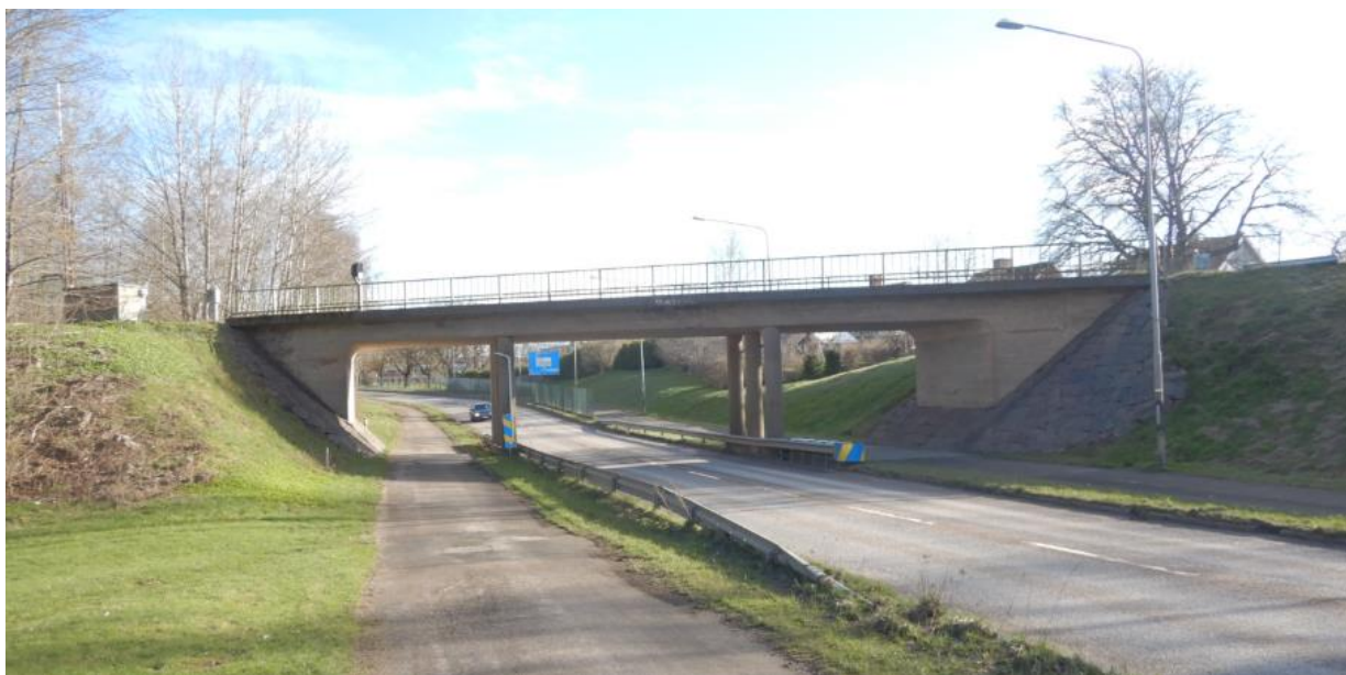
Figur 63. Järnvägsbro för industritrafik norr om Carlsrovägen.
