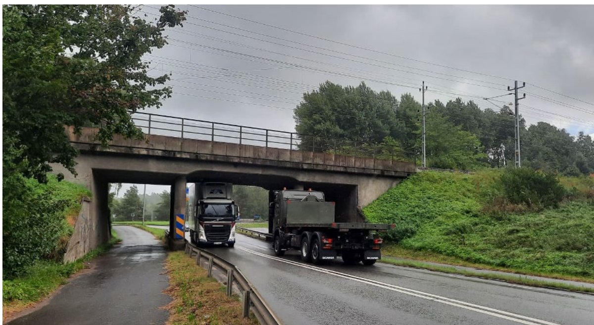
Figur 47. Järnvägsporten i de västra delarna av delsträcka 2. Fotot blickar åt sydost.
