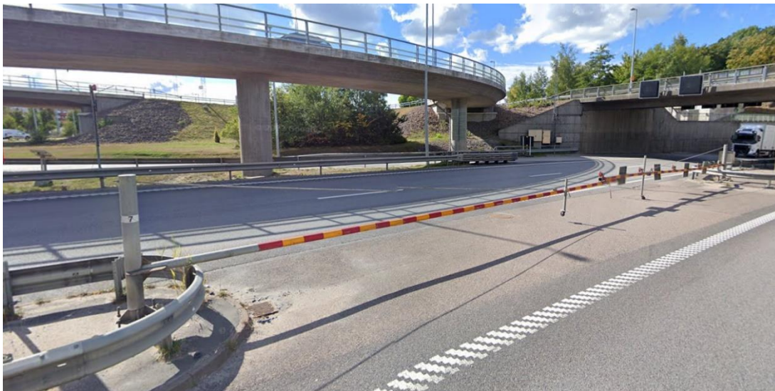
Figur 10. Överledningsyta och bommar vid Lundbytunnelns östra tunnelmynning.
