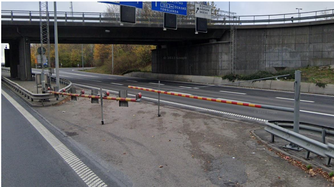
Figur 12. Överledningsyta och bommar vid Lundbytunnels västra tunnelmynning.
