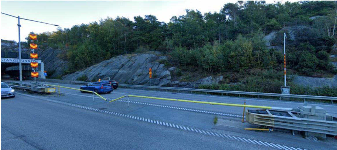
Figur 6. Överledningsyta och bommar vid Gnistångtunnelns södra tunnelmynning.
