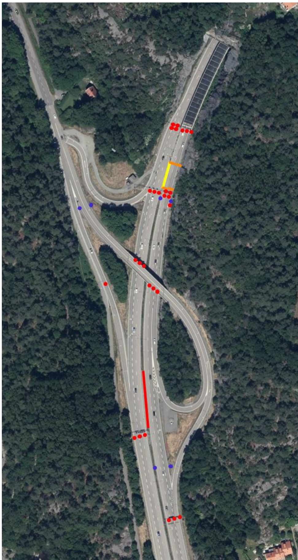
Figur 5. Södra tunnelmynningen med fast avstängningsutrustning markerad.
