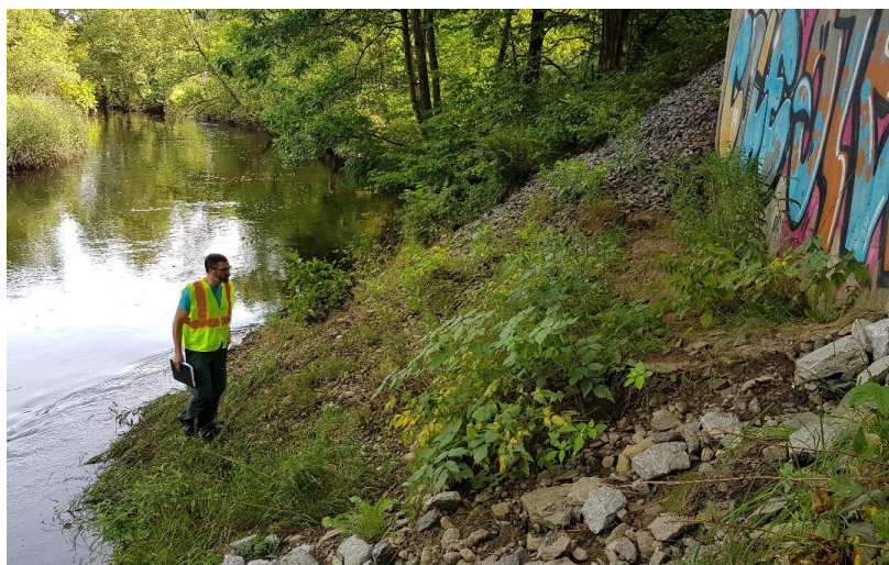
Figur 9. Strandpassage på västra sidan Storån under väg 156. Ytan är brant med grov krossten.
