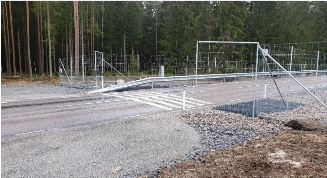
Figur 6. Konmattor och krossten vid stängselsluten hindrar att djur går ut längs med vägbanan istället för tvärs över. Konmattor, alternativt annan tät yta, förhindrar markvegetation, som annars kan attrahera viltet att söka föda. Kontrastlinjer över vägen ska underlätta för trafikanter att upptäcka passerande djur samtidigt som de agerar ledlinjer för djuren.
