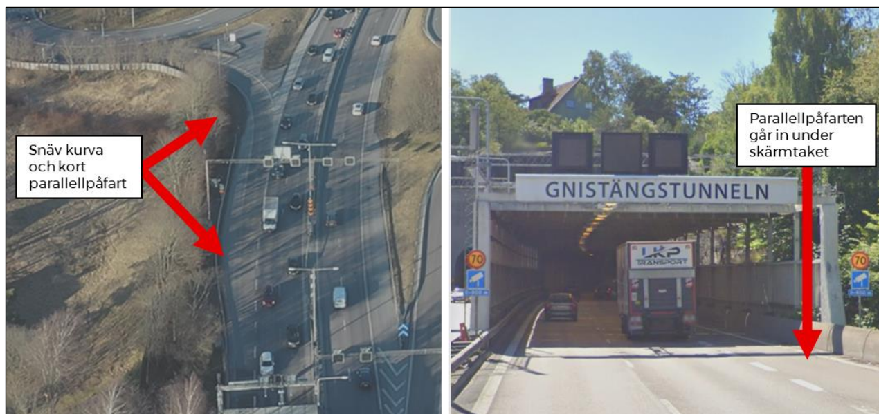
Figur 28. Undermålig påfart i anslutning till Gnistängstunneln (södergående riktning).
