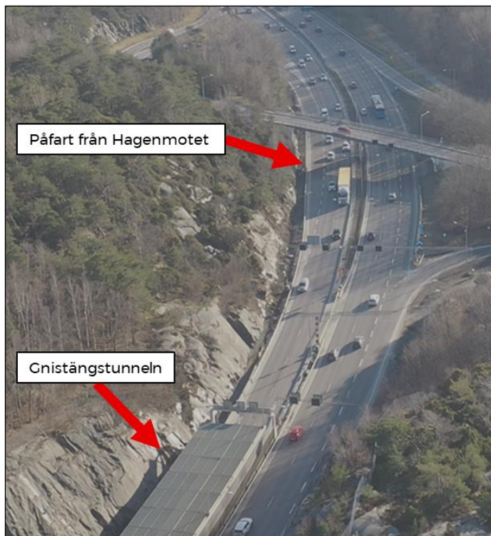
Figur 29. Påfartsrampen från Hagenmotet till Gnistängstunneln i norrgående riktning.
