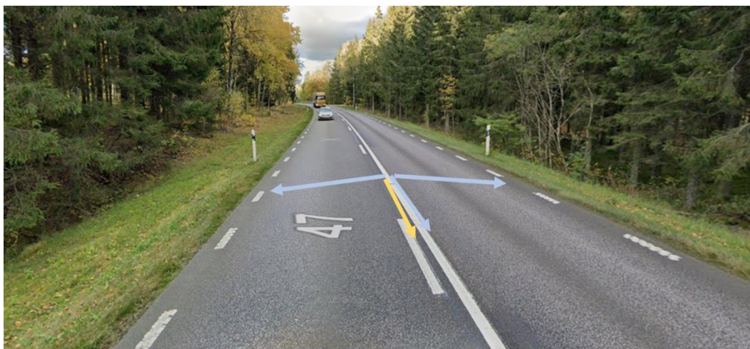
Figur 7. Bilden exemplifierar hur avrinningen ser ut på stora delar av aktuell sträckning av väg 47 och 26, där vägen är kuperad. Vägens lutning är markerad med gul pil och avrinningen med blå pilar. Foto från Google maps, oktober 2020.
