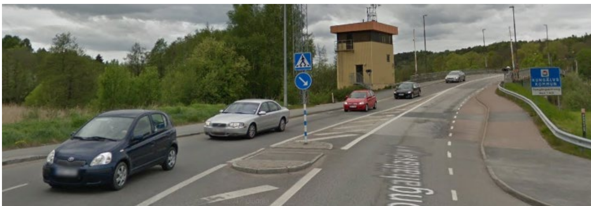
Figur 30. Övergångsstället längre norrut över anslutning till och från Bohusbron, vy norrut. (Källa: Google Maps, 2018).
