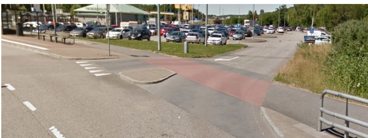
Figur 31. Gång- och cykelpassagen över in- och utfarten (höger-in-höger-ut) till och från pendelparkering längs tillfarten från Jordfallsbron. (Källa: Google Maps, 2018).
