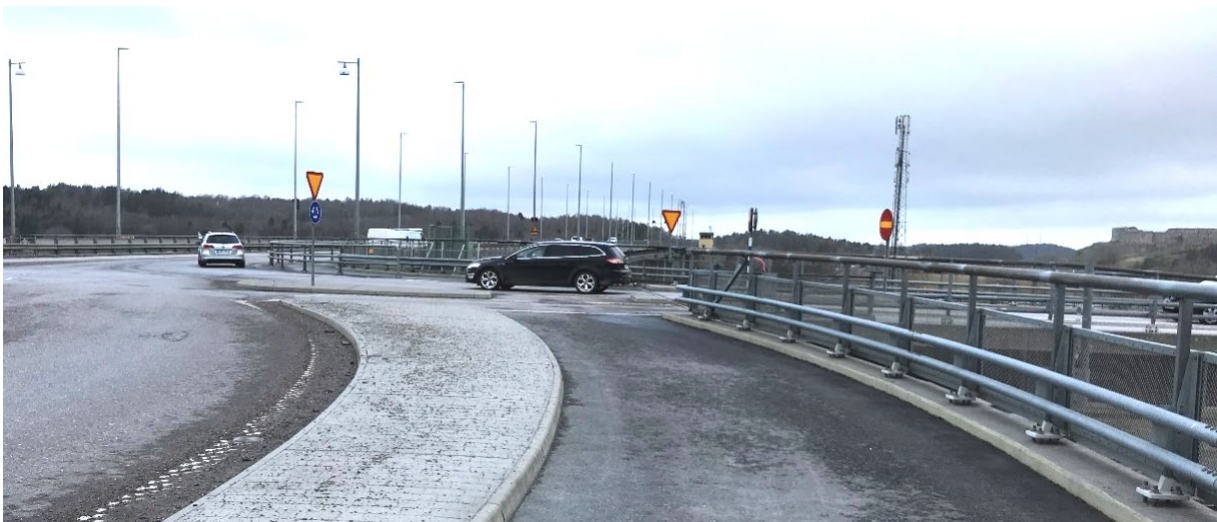
Figur 66. Foto över tidigare utformning, före genomförda justeringar under hösten 2018, längs gång- och cykelvägen genom Bohusmotet i riktning mot tillfarten från avfartsrampen från E45 norr. Av fotot framgår att gående och cyklister längs gång- och cykelvägen tidigare hade svårt att få ögonkontakt med bilister på avfartsrampen.
