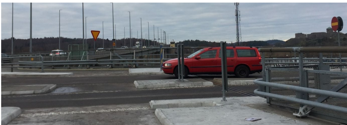
Figur 27. De nya reflexskämarna begränsar till viss del sikten mellan gång- och cykeltrafikanterna och bilförarna. (Källa: Trafikverket, 2018).
