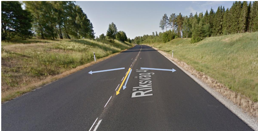
Figur 7. Bilderna exemplifierar hur avrinningen ser ut på stora delar av aktuell del av väg 46. Den övre bilden visar hur avrinningen ser ut där vägen är flack och den nedre där vägen lutar. Vägens lutning är markerad med gul pil och avrinningen med blå pilar. Foto från Google maps, juni 2018.
