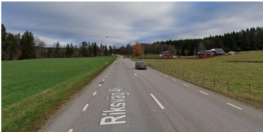
Figur 11. Bild som exemplifierar hur väg 46 ser ut längs aktuell sträckning. Foto från Google maps, augusti 2018.
