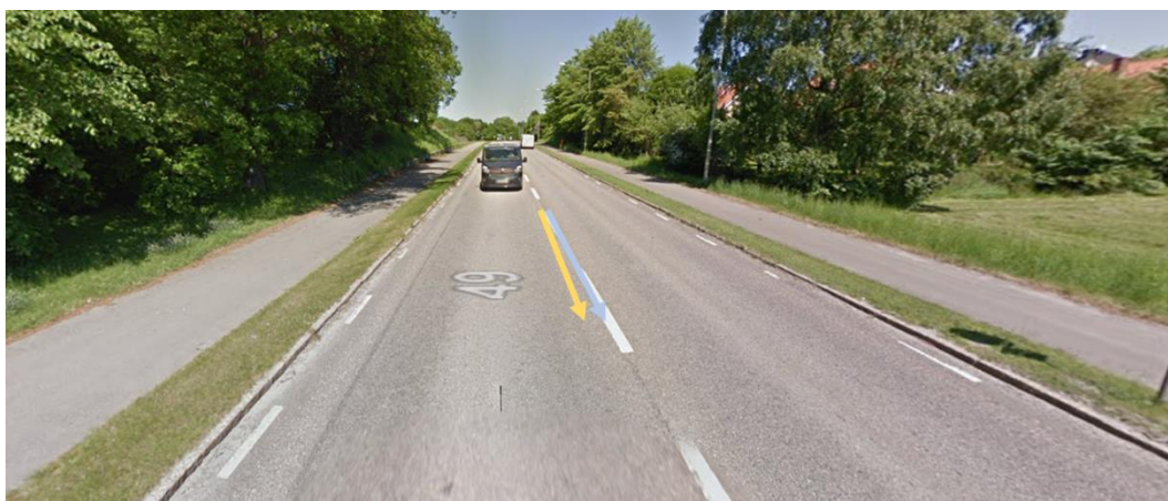
Figur 6. Bilderna exemplifierar hur avrinningen kan se ut på aktuella sträckor på väg 49 och 26. Vägens lutning är markerad med gul pil och avrinningen med blå pilar. Den övre bilden visar en svagt lutande vägsträcka utan kantsten och den nedre visar en relativt kraftigt lutande sträcka med kantsten. Foto från Google maps, juni 2017 och maj 2018.
