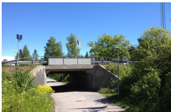
Figur 11. Exempel på planskild GCM-tunnel (Trafikverket)
