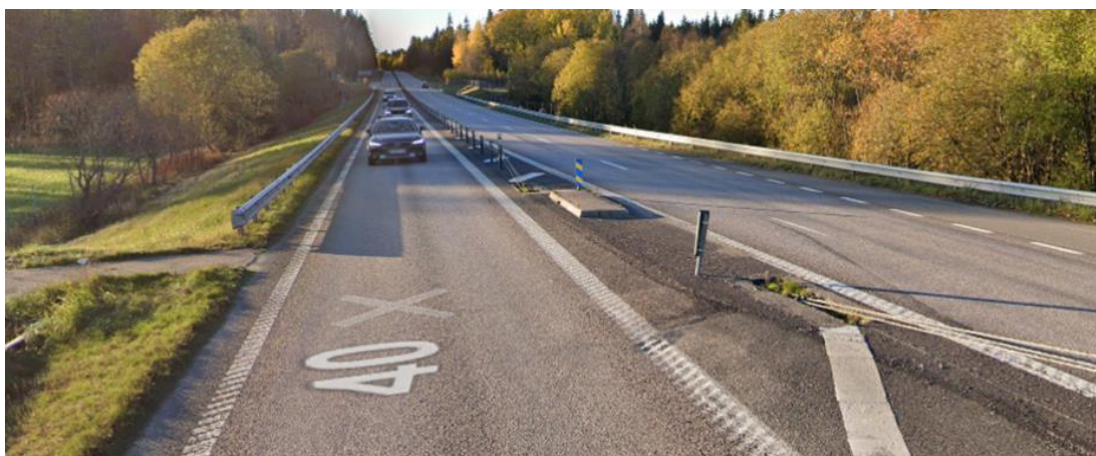
Figur 2. En typisk gångpassage för oskyddade trafikanter vid hållplatserna längs väg 40. Passagerna är generellt smala och har tillkommit genom öppningar i mittförlagt vajerräcke. Skyltad hastighet är 70 km/h respektive 100 km/h vid de olika passagerna. (Google gaturvy).
