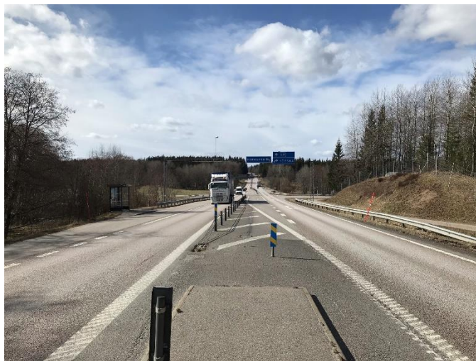
Figur 8. Gångpassage i plan nära hållplatsläge B. Samtliga passager vid de olika hållplatslägena är utformade på samma sätt, dvs med en upphöjd refugdel och små reflexskyltar (COWI, 2021-04-08)
