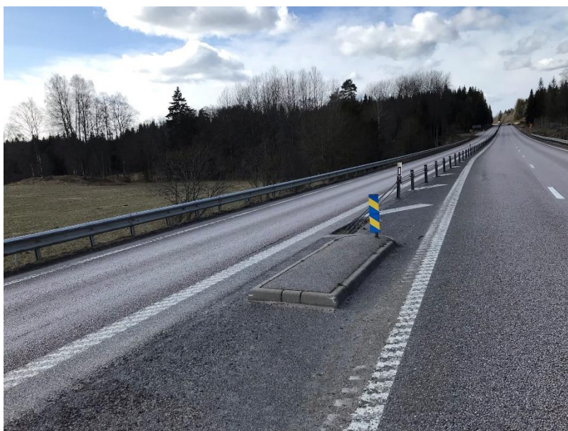
Figur 9. Gångpassage i plan nära hållplatsläge A. (COWI, 2021-04-08)
