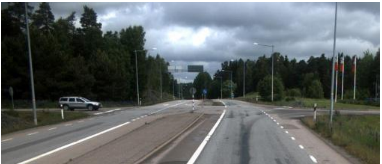
Figur 1. Korsningen E45-Strömstadsvägen sett från söder (Källa: Trafikverket).
