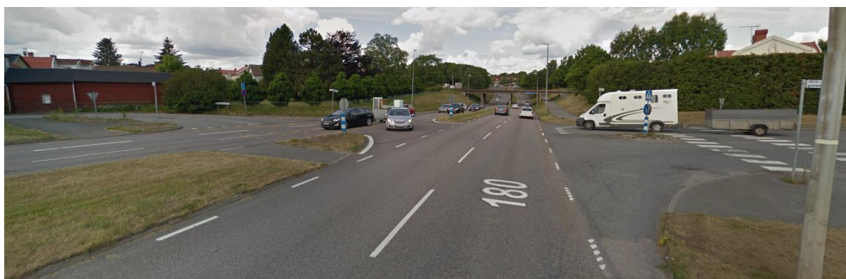
Figur 18. Korsning väg 180-Götgatan/Järngatan norr om Götaplan, sett i riktning från Götaplan och norrut längs väg 180. (Foto: Google Maps).
