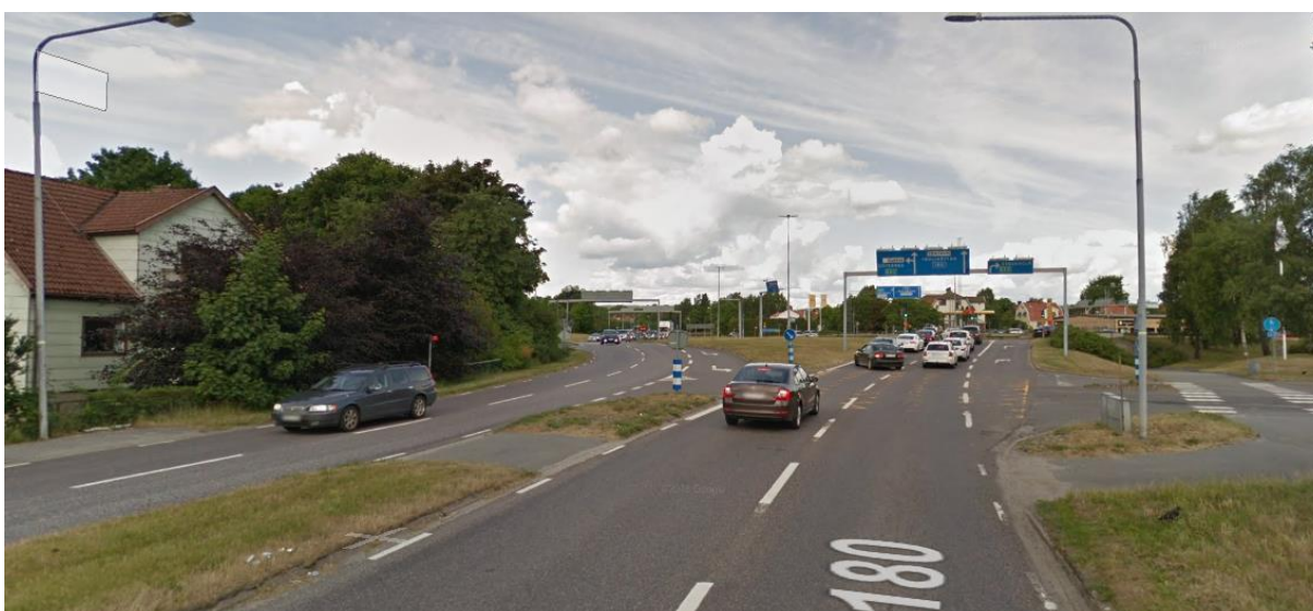
Figur 20. Korsning väg 180-Kristineholmsvägen söder om Götaplan, sett från väg 180 i riktning norrut. Närmast i bilden syns gång- och cykelpassagen över väg 180. (Foto: Google Maps).
