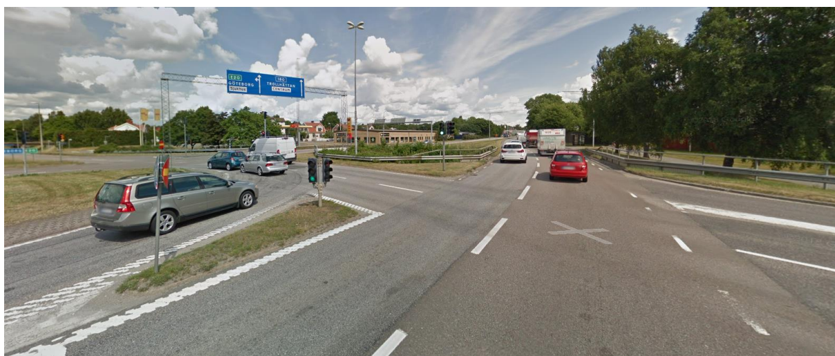
Figur 17. Korsningen Götaplan sett från E20 väster i riktning österut. Bilden visar korsningspunkten med tillfarten från väg 180 söder i riktning norrut. Till vänster i bilden syns vänstersvängande från E20 väster mot väg 180 norr tillsammans med låga signalstolpar inne i korsningen. (Foto: Google Maps).
