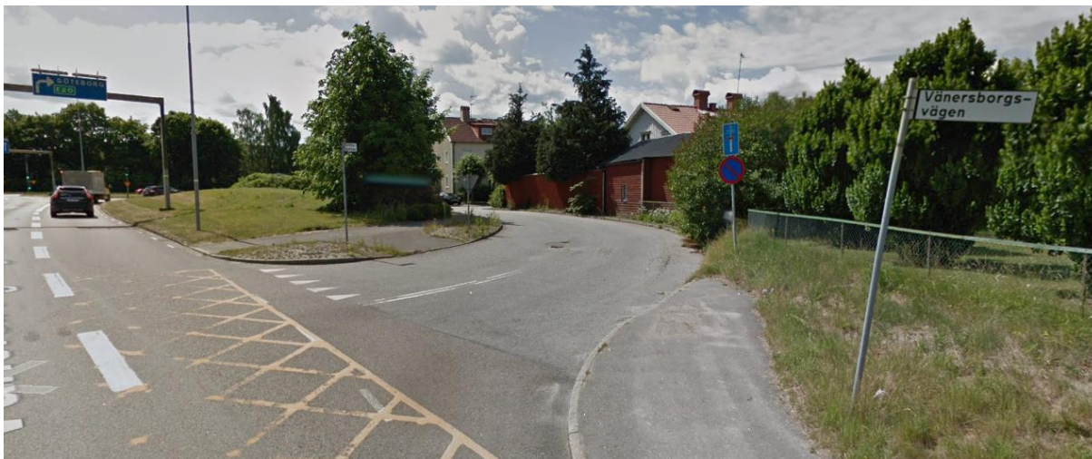
Figur 19. Anslutningen från Götagatan till väg 180, sett från väg 180 i riktning mot Götaplan. I bilden syns även gångpassagen över Götagatan. (Foto: Google Maps).
