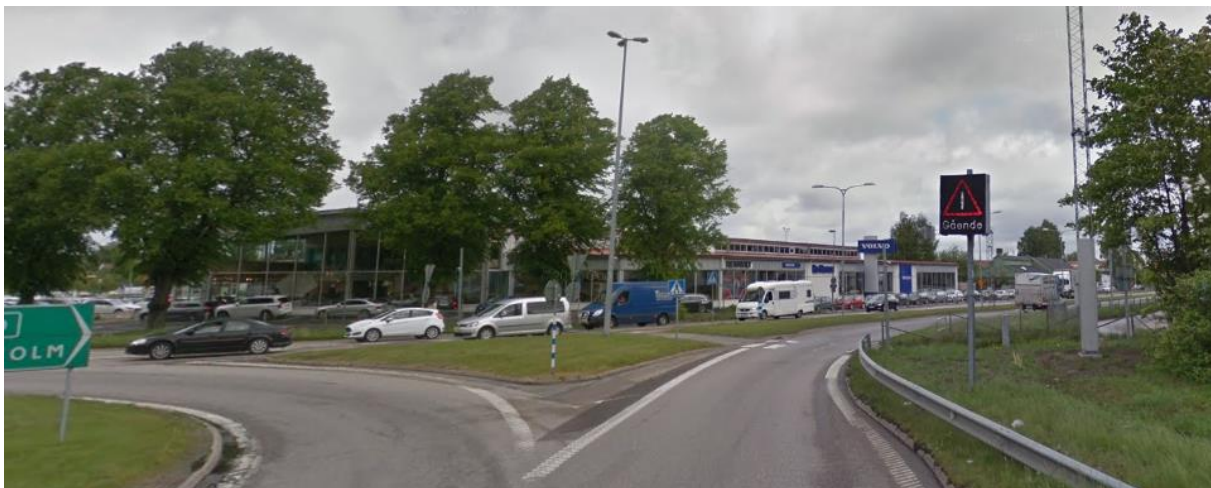
Figur 9. Gång- och cykelpassagen öster om Sveaplan, med tillhörande VMS-skylt som varnar för gående och cyklister på övergångsstället i riktning österut. (Foto: Google Maps).
