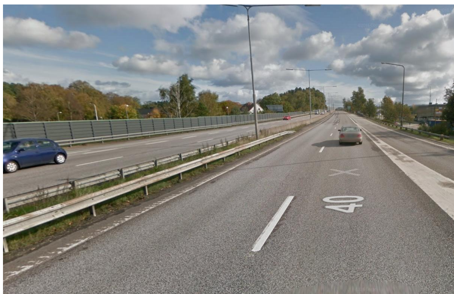
Figur 8. Foto som visar ett avsnitt av väg 40, väster om järnvägsbron vid övergång från balkräcke till betongräcke i mittremsan. Hastighetsbegränsningen här är 80 km/h. Källa: © Google Maps.
