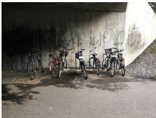
Figur 56. Cykelparkering vid Hovås Nedre, placerad i gång- och cykeltunnel.
