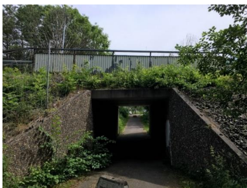
Figur 75. Bristande stängsel vid Lyckekullavägen, Särö
