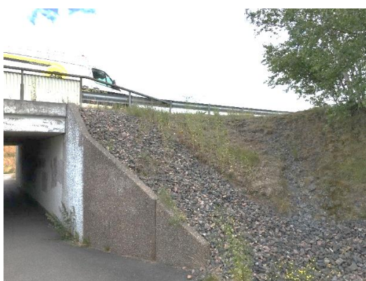
Figur 76. Gång- och cykeltunnel intill pendelparkeringen vid Vallda trekant, där viltstängsel saknas. I slänten syns även en djurstig.
