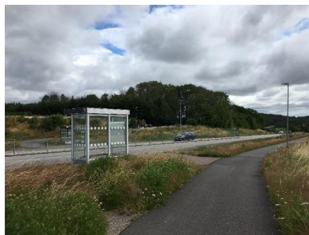
Figur 71. Hållplats Vallda trekant, bristande belysning.
