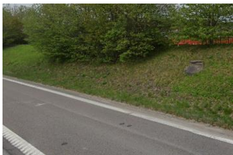
Figur 52. Betongbrunn intill vägbana, Hovåsmotet.
