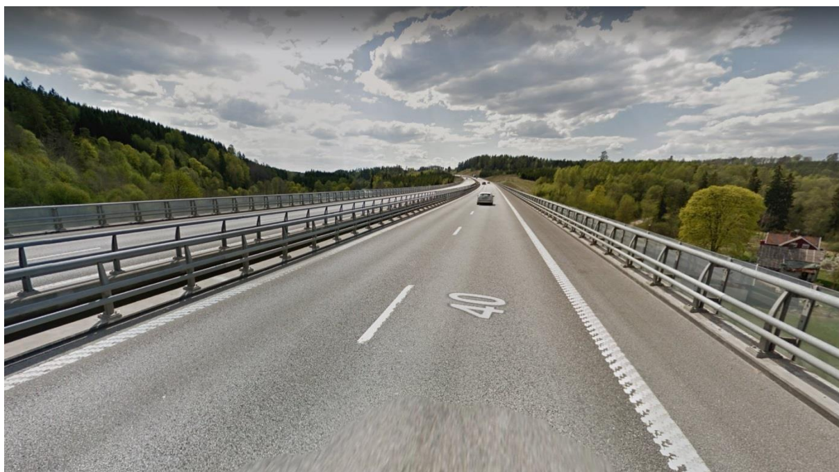
Figur 8. Ett avsnitt av väg 40 på delsträcka A, vy mot sydväst från Rångedalabron. Källa: © Google Maps.
