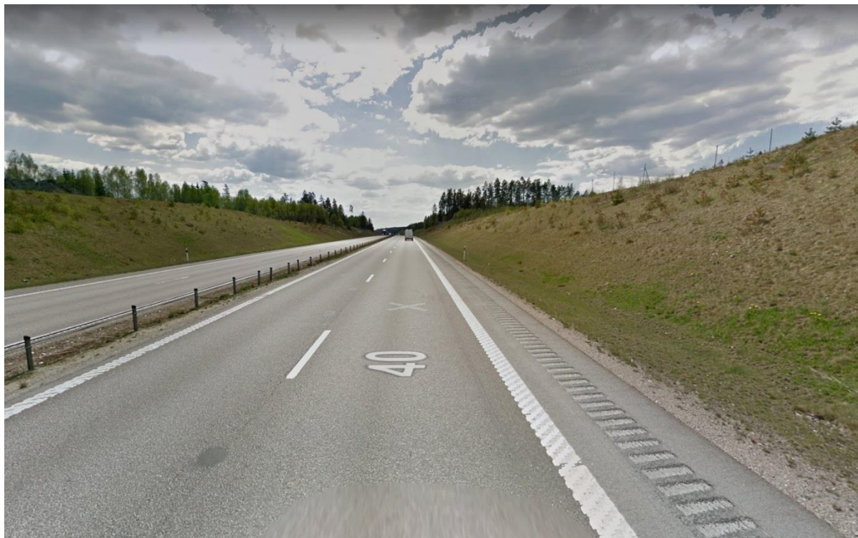
Figur 9. Ett avsnitt av väg 40 på delsträcka B, vy mot söder. Källa: © Google Maps.
