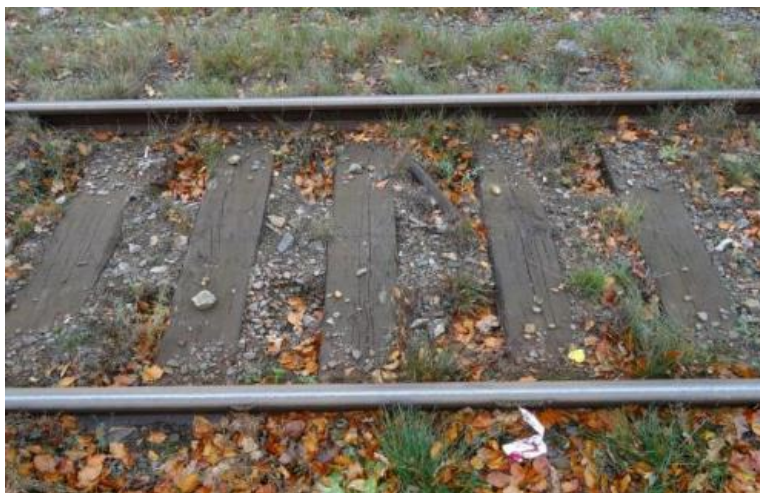
Figur 39: Bild som visar på banöverbyggnadens låga kvalitet.
