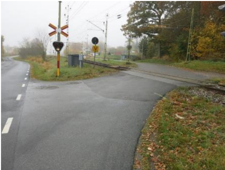
Figur 40: En av många plankorsningar med låg skyddsnivå.
