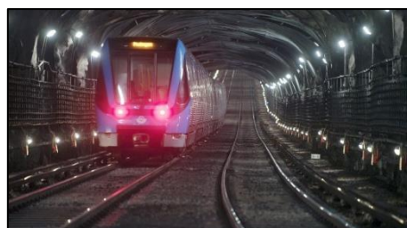
Figur 18 Tunnelbana i Stockholm
