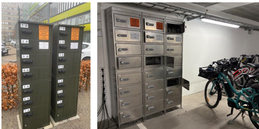
Figur 2. Exempel på förvarings- och laddningsskåp med låsbara fack och eluttag.
