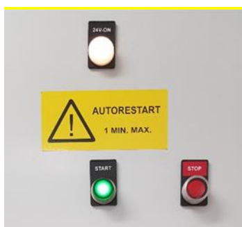
Figur 3. Strömknapp i teknikrummet NÄL.
