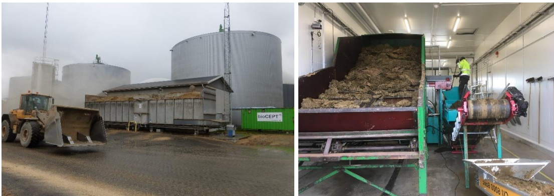
Figur 16. Exempel på mottagningsficka för ensilage. T.V. ett exempel från Jordberga Biogasanläggning och T.H. avlastarbordet på naturbruksskolan Sötåsens pilotanläggning för grön bioraffinering.
