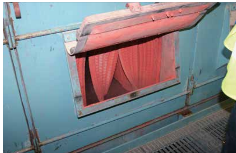
Inspektionslucka i ITK-filtret.
