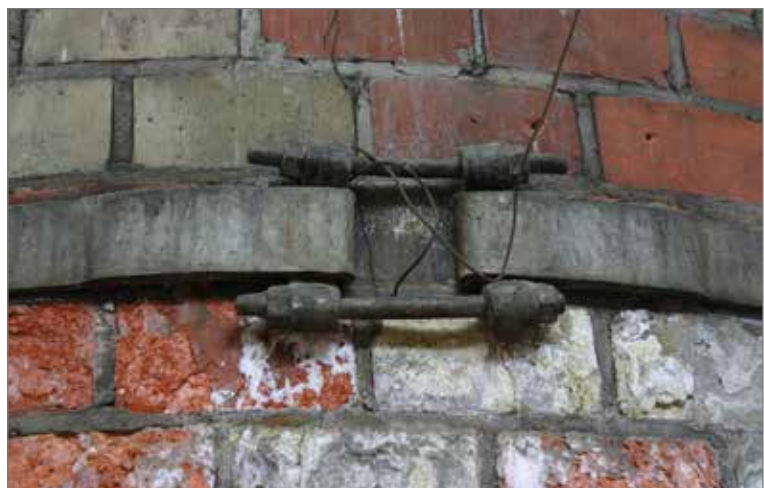
Bandet runt skorstenen. Dessa finns med jämna mellanrum runt skorstenen upp mot krönet.
