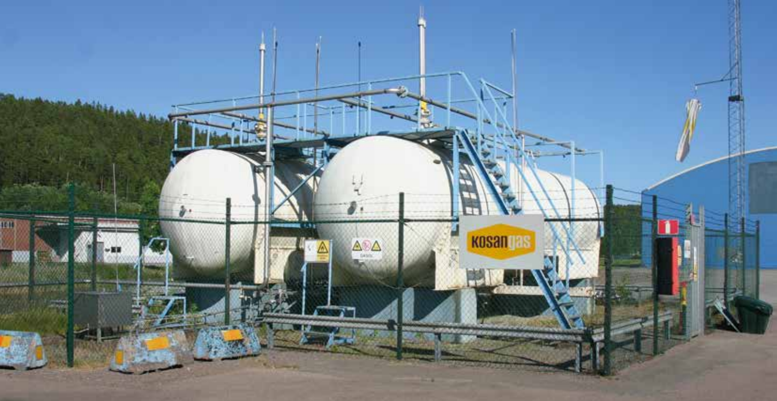
Gasolcisterner strax norr om byggnad 8. Gasen har använts till att driva torkarna till TM 2.
