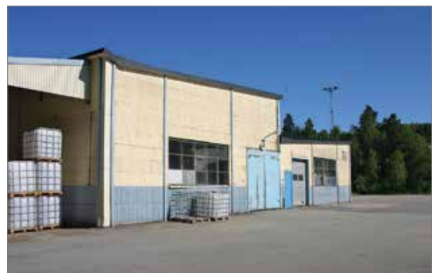
Byggnad 5. Foto från söder.
