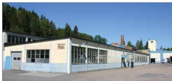
Byggnad 5 från sydost. I bakgrunden till höger byggnad 3. Foto Patrik Olofsson.
