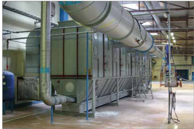
Dan Webb-filtret. Bakom väggen till vänster ligger lokalen där TM 2 är belägen.
