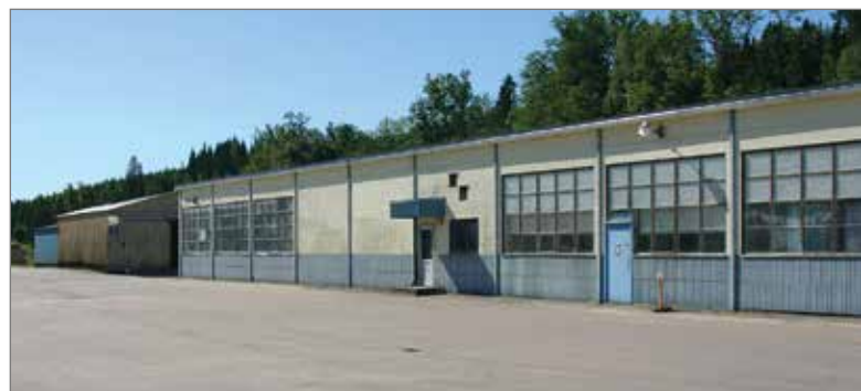
Byggnad 5 från norr med byggnad 7 i bakgrunden.
