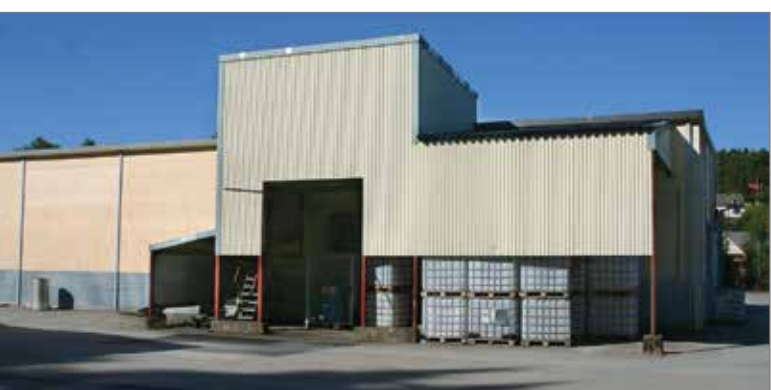
Byggnad 5. Sydöstra hörnet med tillbyggnaden från 1978.
