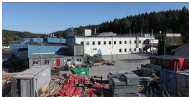
Foto mot söder från bron över kraftverket. Till vänster byggnad 3 och den ljusa till höger är byggnad 1 med bland annat kontor och laboratorium.
