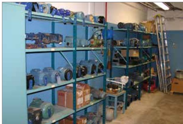
Motorförråd, norra delen av byggnad 1.
