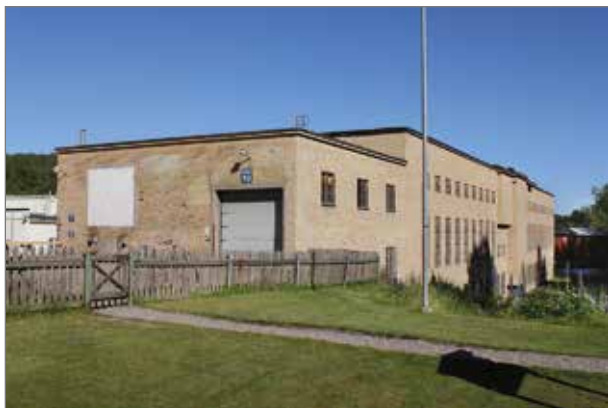
Foto från öster. Byggnad 2.
