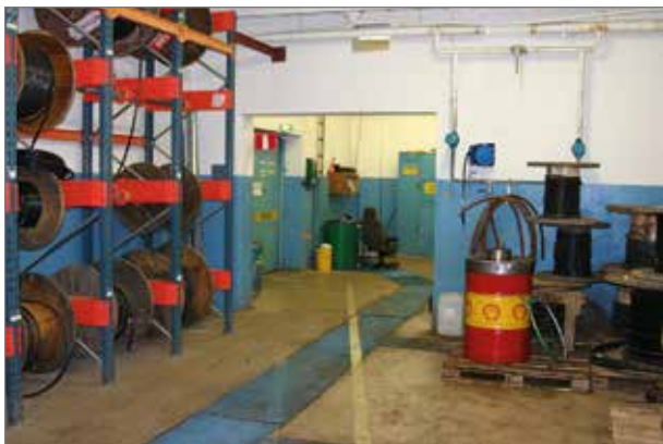
Kabelförråd. Foto mot oljeboden. Norra delen av byggnad 1.
