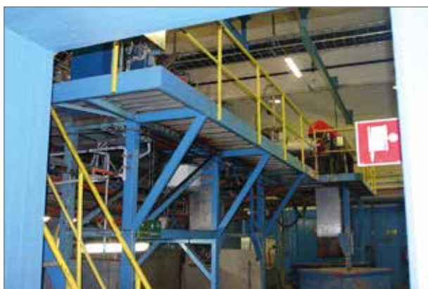
Byggnad 1b. Vattenverket för spillvatten. Foto upp mot andra våningsplan.
