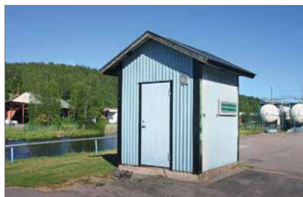
Pumphus tillhörande Bengtsfors kommun som uppfördes när kommunalt vatten och avlopp anslöts till ön.
