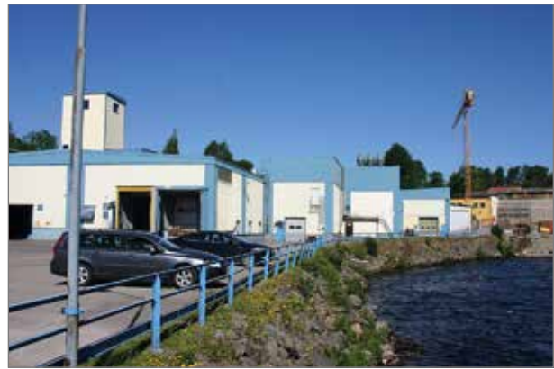
Foto från brofästet till södra bron mot byggnad 3. Till höger syns kraftverksbygget.
