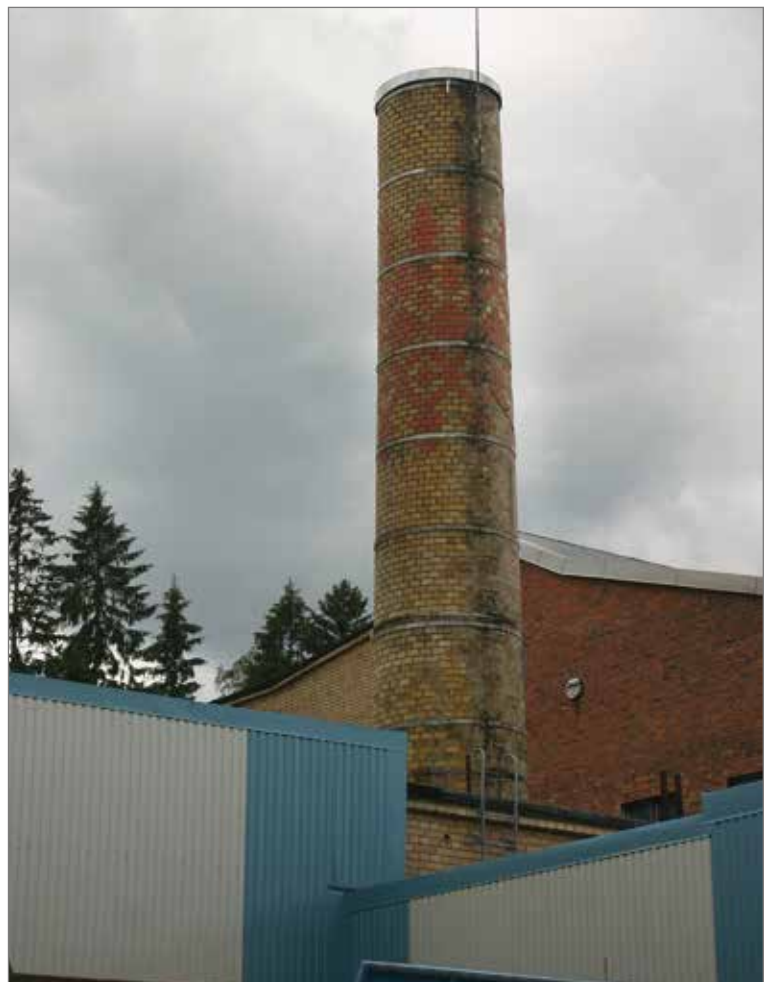
Skorstenen har en utsmyckning i teglet. Denna typ av utsmyckning och arkitektonisk utformning av industriskorstenar var vanlig fram till slutet av 1910-talet.
