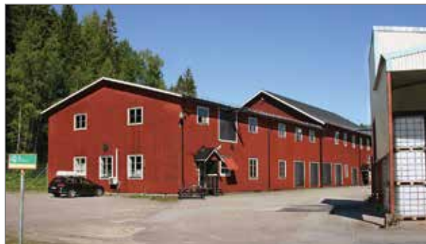
Från vänster. Byggnad 6b och 6a. Till höger skymtar byggnad 5 och tillbyggnaden vid dess sydvästra hörn från 1978. Foto från söder.
