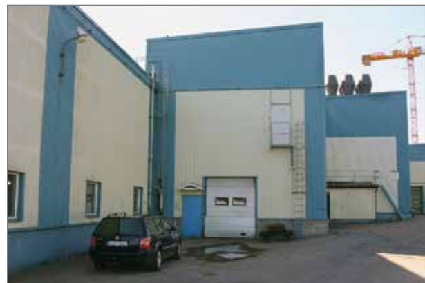
Byggnad 3. Foto från söder. Kranen till höger tillhör kraftverksbygget.
