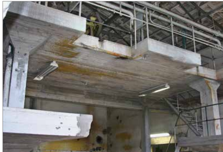
Byggnad 2, våning två. Samma som föregående bild.
