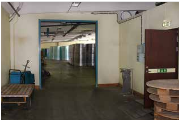
Foto mot norr i byggnad 5. Till höger syns personalutrymmena.
