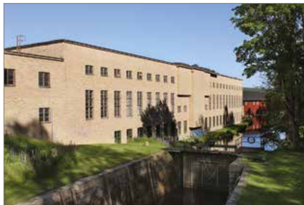
Foto från öster. Byggnad 2. Vålbevarad 1950-tals fasad. Längst till höger skymtar byggnad 6a.
