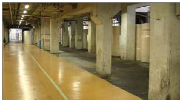
Byggnad 2. Papperslager. Fönstren ut mot Dalslands kanal skymtar till höger i bild.
