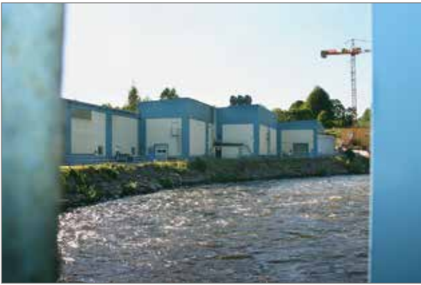
Foto från södra bron mot byggnad 3 där TM 2 är belägen.
