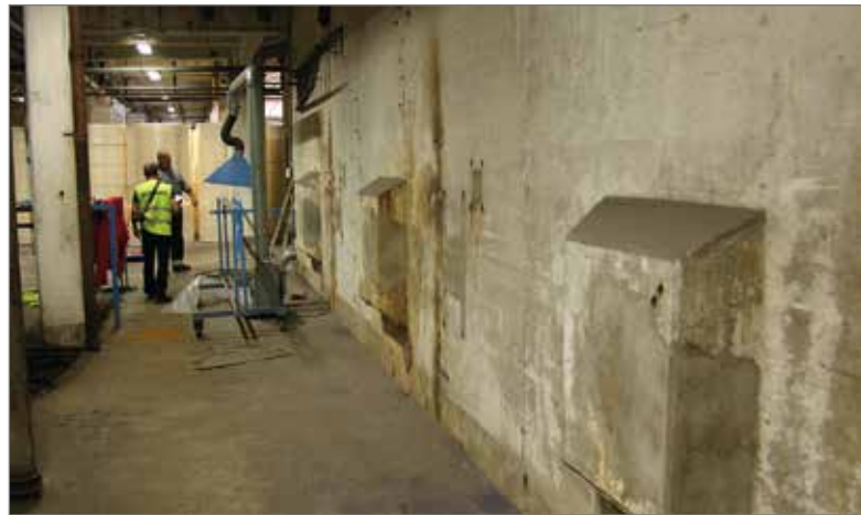
Byggnad 2, till höger syns betongväggen mot PM3:s maskin- kar.
