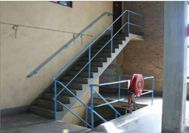
Trappa till det äldre dusch- och omklädningsrummet. Byggnad 2.
