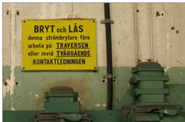
Även här upplyses om vikten av säkerhet vid arbete.
