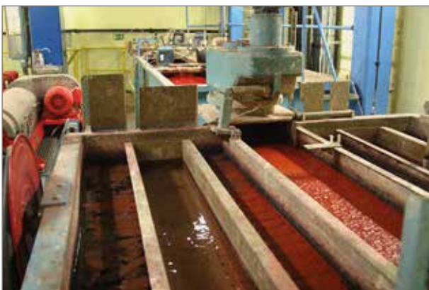
De olika reningsnivåerna. Orenat vatten till höger och renat vatten till vänster.
