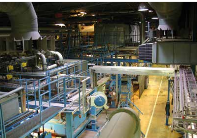
TM 2 och foto i riktning söderut mot RM 4 och färdig produkt. Till höger utanför bild på bottenplan ligger kontrollrummet.
