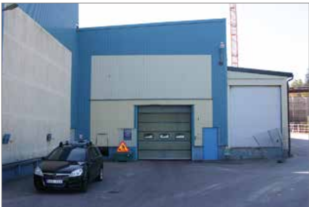
Byggnad 3. Foto från söder. Inlastningen till massalagret i porten rakt fram. Till höger skymtar kraftverksbygget.
