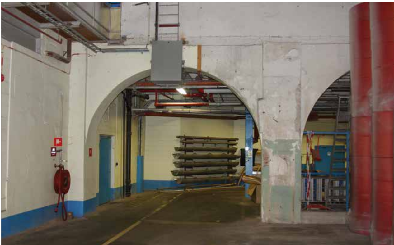
Byggnad 1. Papperslager och materialförråd. Foto mot norr.
