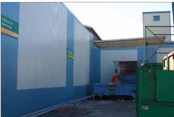
Återvinningsplats, foto från söder. Till vänster byggnad 4a.
