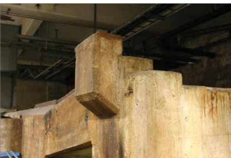
Byggnad 2, stabila betongfundament och ett äldre massakar.
