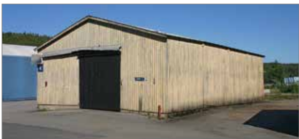
Byggnad 7. Till vänster i bild skymtar lagertält/byggnad 8.
