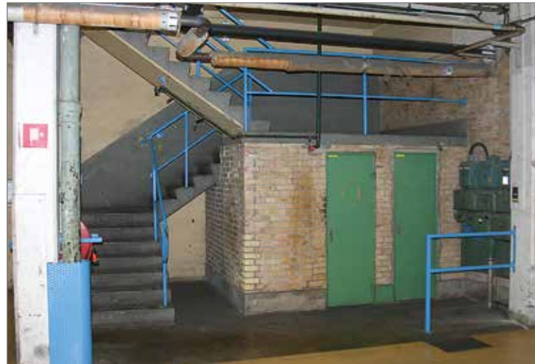
Trappor upp till plan 1, byggnad 2. Under trappan finns två toaletter.
