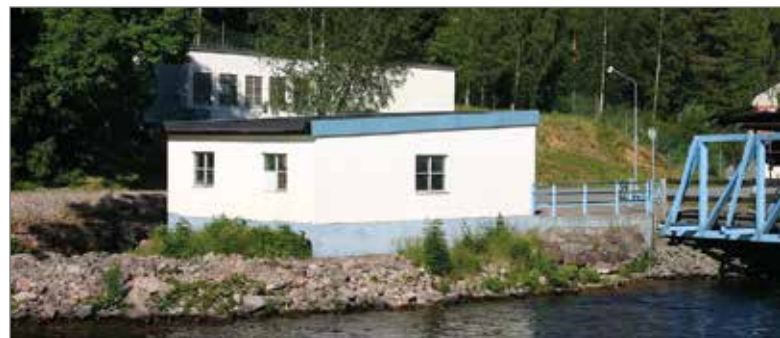
Garage, byggnad 10, från nordost med valsliperistaden i bakgrunden.
