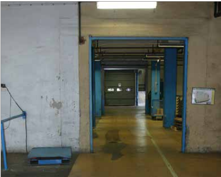
Vy från byggnad 2 bort mot porten in till TM 2.
