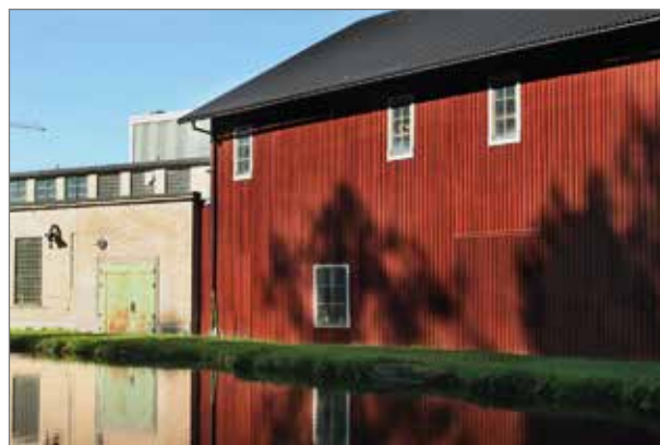
Foto från sydväst. Bakom metallporten finns en liten byggnad kallad 4b som en liten kil in mellan 4a och 6a. Till höger byggnad 6a.
