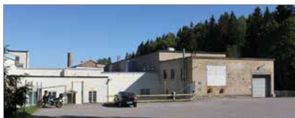
Foto mot söder och här sluts cirkeln på de exteriöra fotona. Byggnad 1 till höger och till vänster byggnad 3.
