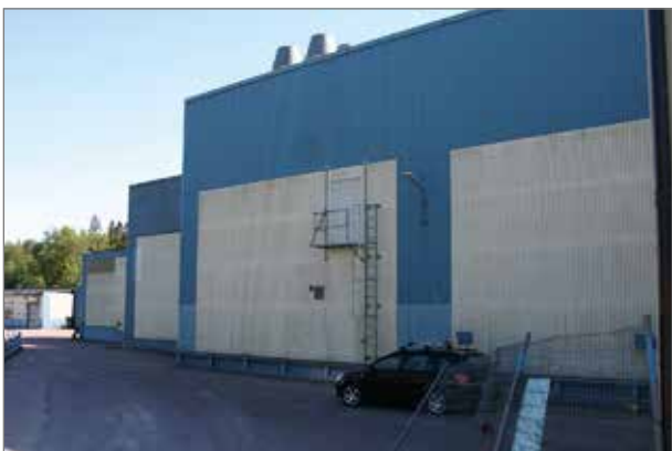
Byggnad 3. Foto mot söder.
