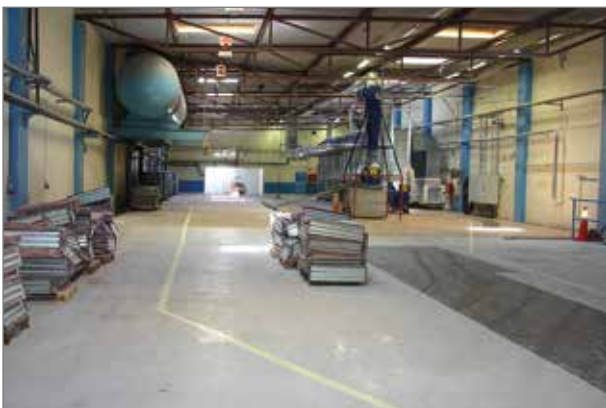
Byggnad 1d. Foto mot norr. Till vänster syns cisternen för sprinklersystemet och till höger en bit bort syns Dan Webb-filtret.
