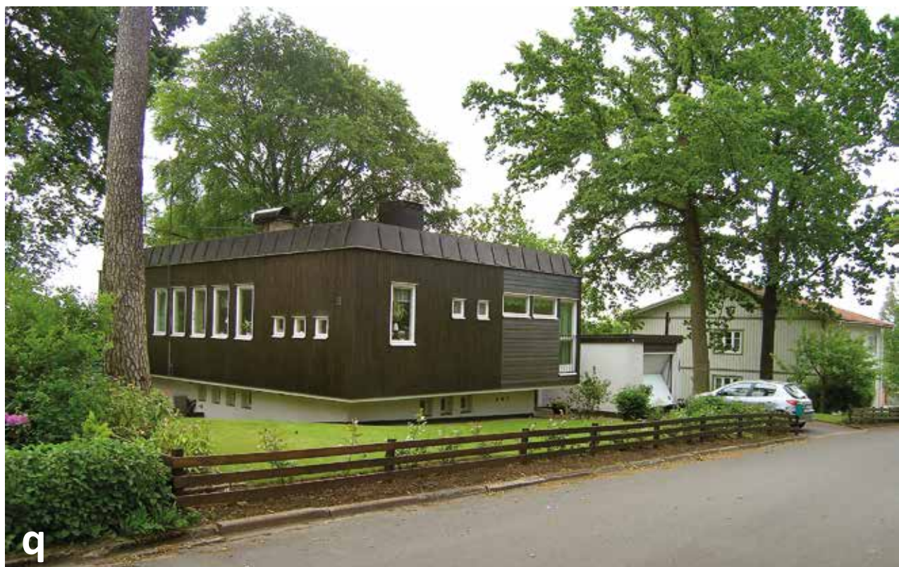
Villa Jonsson är en modernistisk villa uppförd på Tallbacken i Skövde 1960–61. Den ligger i samma område som ovan nämnda Villa Tesdorpf och har liknande drag. Dess panelklädda, brunlaserade övervåning kragar ut över en spritputsad suterrängvåning. Huset omramas av tallar och vänder sig från gatan, och får mot trädgården två fulla våningar. Arkitekt var Jørgen Lorenzen. Foto Erik Holmström.
