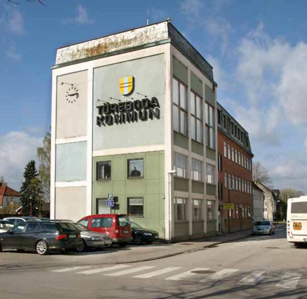
Töreboda kommunhus av arkitektkontoret Gyllenberg & Thorén från 1954 består av två delar; en putsad del mot Drottninggatan och torget samt en tegelbyggnad längs med Börstorpsgatan. Den putsade byggnadskroppen utgör den representativa delen med sessionssal med mera. Tegelhuset, som stilmässigt är mer återhållsamt, innehåller kontor för den kommunala förvaltningen. Båda delarna har inslag av påkostade material som skiffer och koppar. Foto Ulf Larsson.
