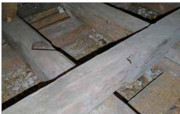
Bjälkarna har busade respektive genomgående knutar för bladdade stödben som varit fästa med dymling.
