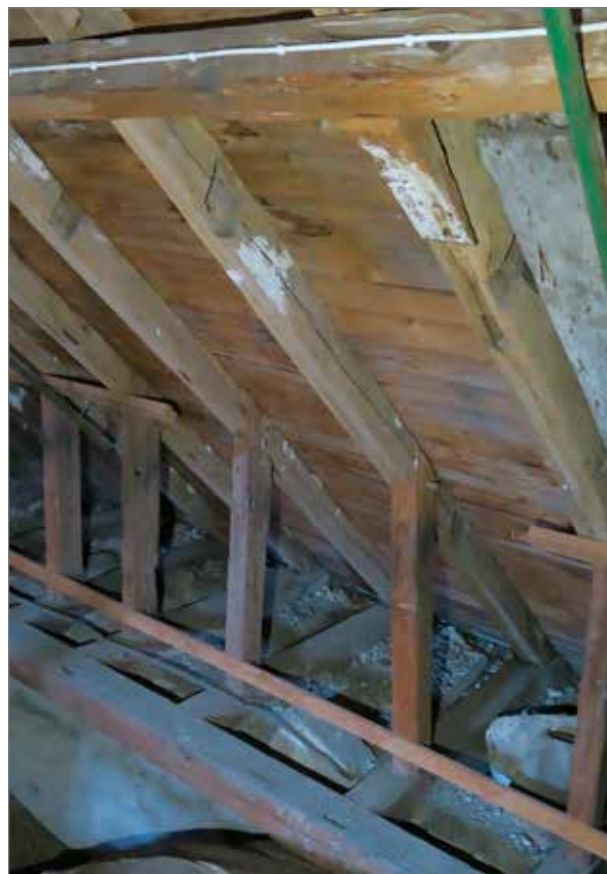
I långhusets takstolar finns återanvända högben av ek av två olika typer, den ena med genomgående spikad knut samt tapphål och den andra med dymlade knutar med nacke, av senmedeltida karaktär.
