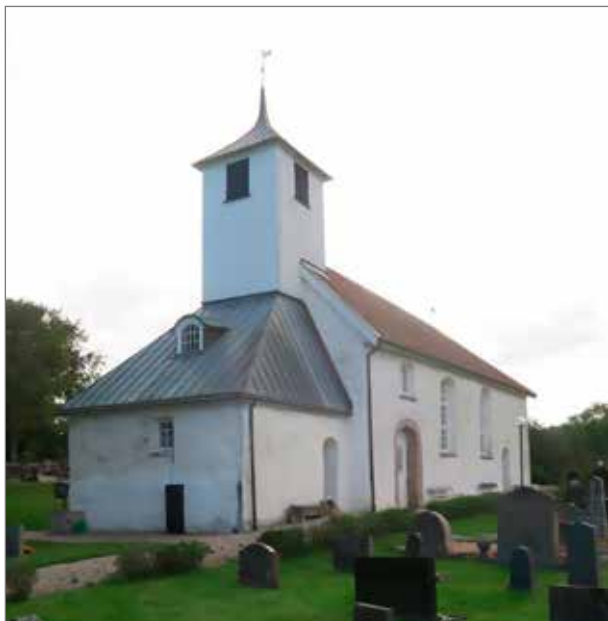
Bottna kyrka från sydväst. Vapenhuset från 1700-talet rymmer furu- och ekvirken från en äldre takkonstruktion.
