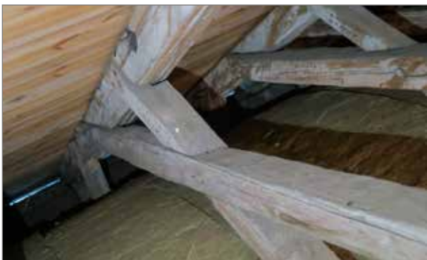
Märkning i form av små borrade hål vid södra sidans knutar.
