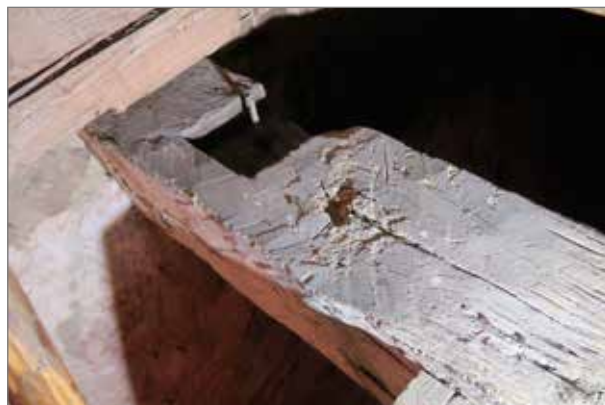
Återanvänd (bind?)bjälke av skarpkantad ek med husad knutar efter stödben, använd som bjälklag i tornet.
