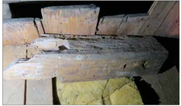
Kapad bindbjälksände på långhusvinden, troligen del av ett tidigare taklag från senmedeltid.
