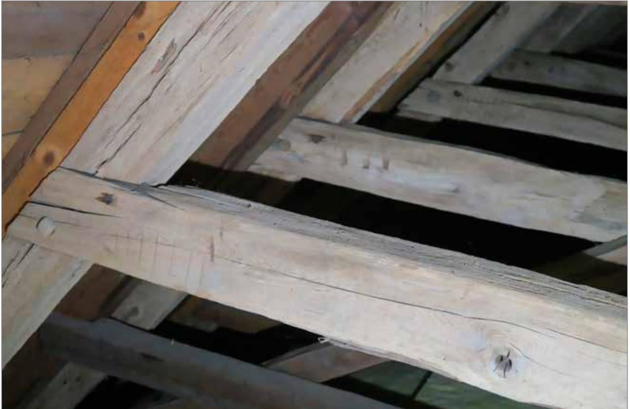
Hanbjälkar av skarpkantad ek med timmermansmärkning, Strävalla kyrka. Märkningen är inte längre konsekvent, varför det kan antas att takstolarna delvis monterades ned och återuppsatts vid senare ombyggnad av innertaket.
