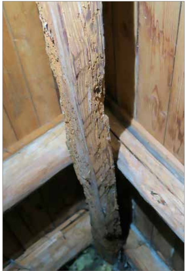
Som nockås i långhuset löper en vittrad bjälke med spår av sprätthuggning, troligen en återanvänd tidigmedeltida byggnadsdel.
