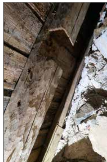
Diagonal behuggning på högben, utförd med knivlipad yxa, vilket ger ett mer tidigmedeltida utseende. Selskiftet 1400?
