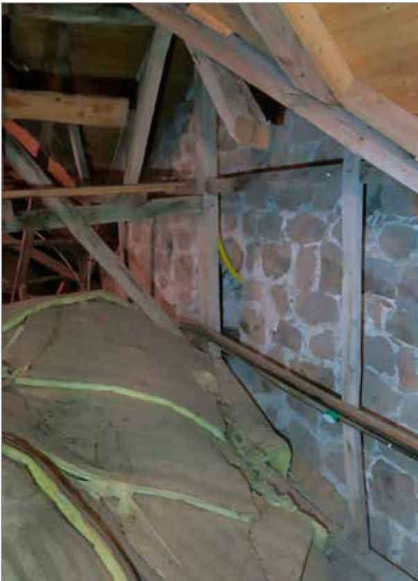
Den östligaste takstolen i långhuset med kungsstolpe.
