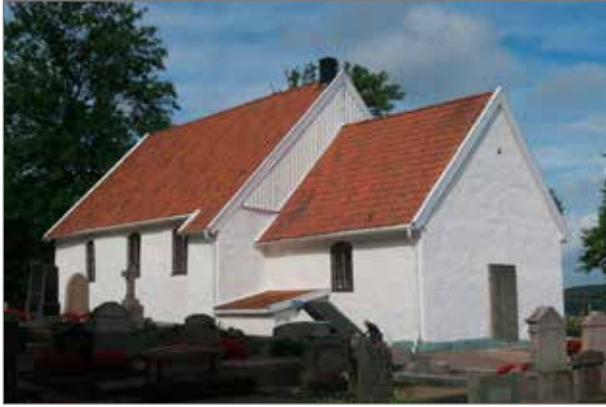
Tuve kyrka från sydost. En av få kyrkor i västgötadelen av stiftet som har kvar ursprunglig planform. Notera den lilla korsformiga ljusgluggen i korets gavelröste.
