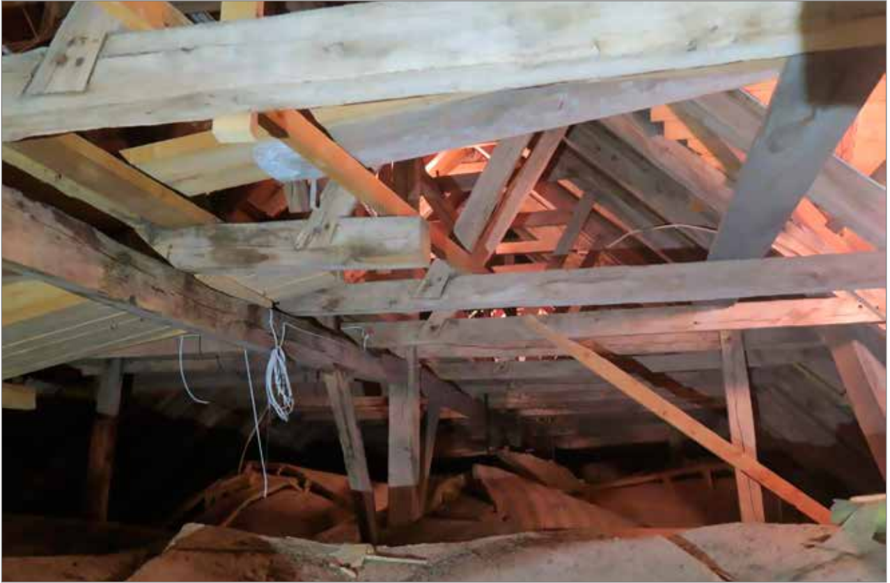
Taklag av ek med långstol i Veinge kyrkas långhus, sannolikt samtida med valven. Fotografi från nordost.
