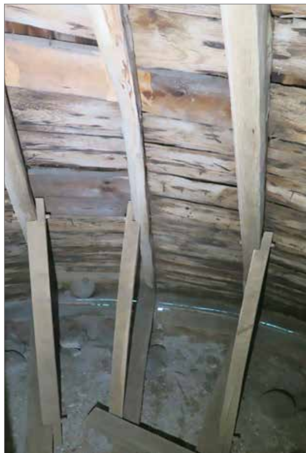
Absiden har kvar sin ursprungliga takkonstruktion av sprätt-huggen ek. Stödbenen är dock utbytta.
