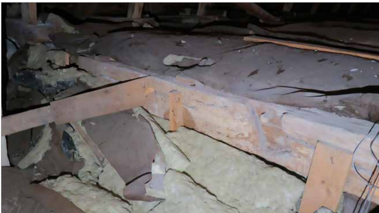
Äldre, vittrad bindbjälke av ek längst i öster på långhusvinden, Kvibille kyrka.
