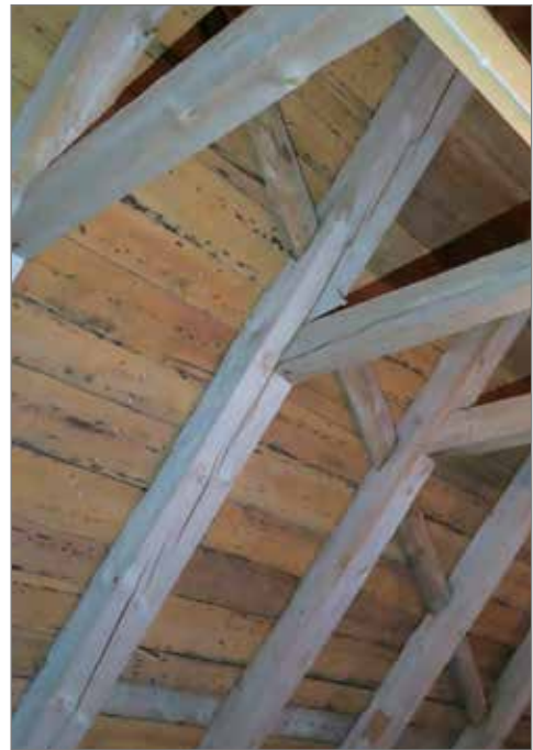
Takfallen har diagonalt löpande längdförsträvning som förefaller vara ursprungliga.
