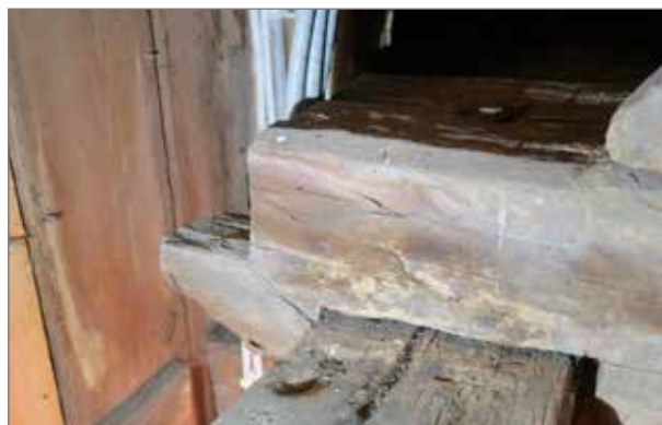
Ekbjälke återanvänd i tornbjälklag, möjlig ände på en före detta bindbjälke.
