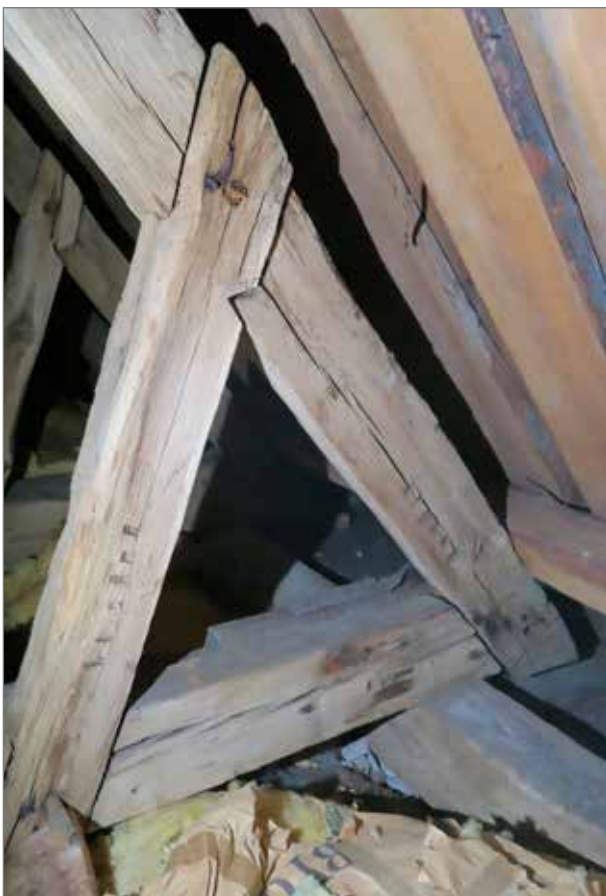
En av knäbockarna där man kan notera numreringen i form av inhuggna jack och knutarna med låsande nacke, typiskt för senmedeltida taklag.
