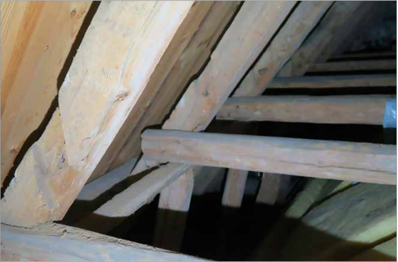
Högbenen i korets takstolar har urtag efter nu försvunna stödben. Troligen har takstolarna ursprungligen bestått av bindbjälke, högben, två stödben och hanbjälke. Okänd ålder, möjligen senmedeltid. Dagens hanbjälkar och stödben är senare tillkomna, troligen samtida med 1700-talets trävalv.
