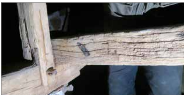
Äldre bindbjälke med brännmärke. Skyddseld för att förhindra bränder? Dylika svårförklarade brännmärken förekommer ibland i medeltida taklag.
