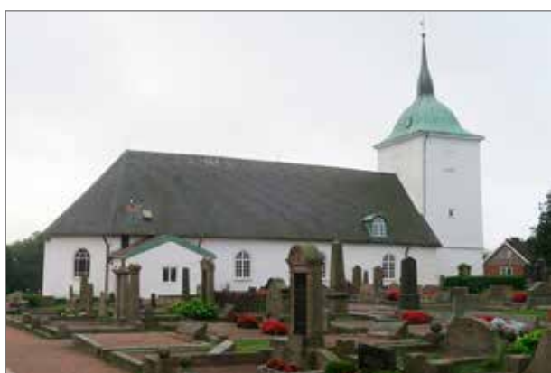
Sävö kyrka från norr. Kyrkan fick sin nuvarande längd 1729 och taklaget är resultatet av denna ombyggnad och en inbyggnad av trävalv 1696. Delar ur ett äldre taklag ingår dock.
