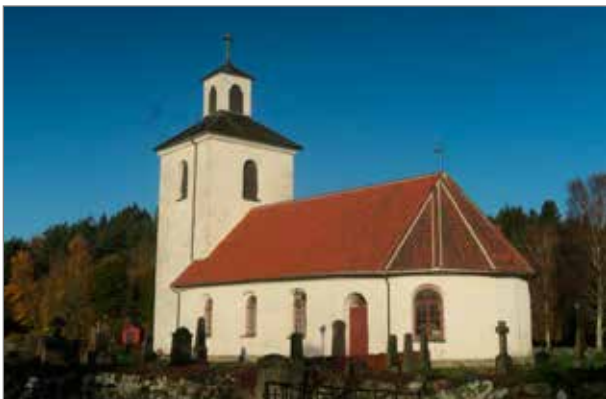
Gällinge kyrka från sydost. Koret byggdes 1765 och tornet 1828.
