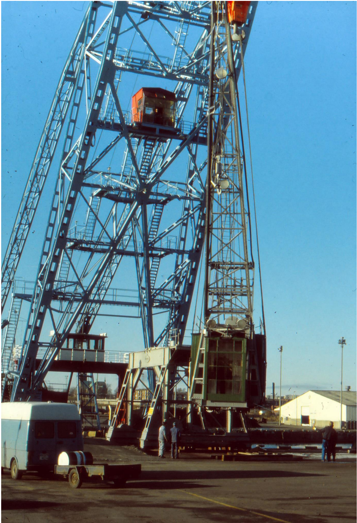
Hytt och maskinrum lyfts upp på portalen i Sannegårdshamnen efter renoveringen sommaren 1985. Under styrhytten på pontonkranen syns Lundby nya kyrka. Foto Bengt Bucht, Sjöfartsmuseet.
