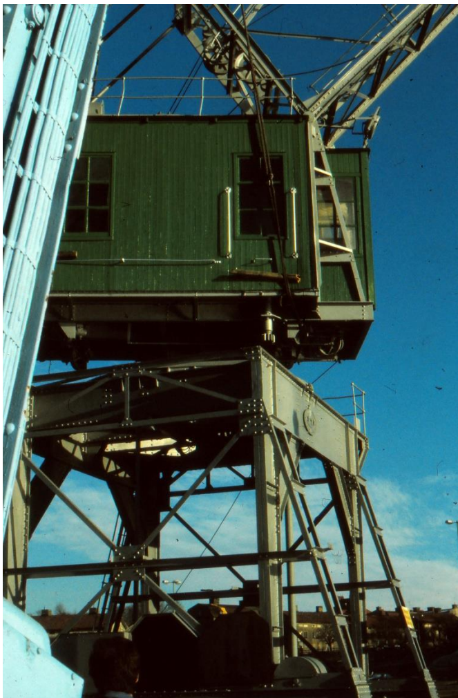
Kran 50. Maskinrum och hytt svävar över portalen. Foto i Sannegårdshamnen, juni-juli 1985. Foto Bengt Bucht, Sjöfartsmuseet.
