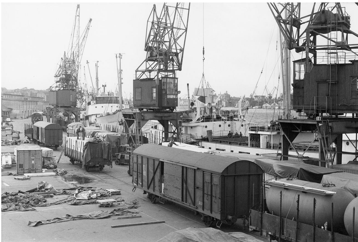
Masthuggskajen 1960-tal. Kranarna 18, 19 och 20 är tillverkade av Götaverken. Kranarna är av något mer modernare snitt än kran 50. Foto www.goteborgshamn.se img092
