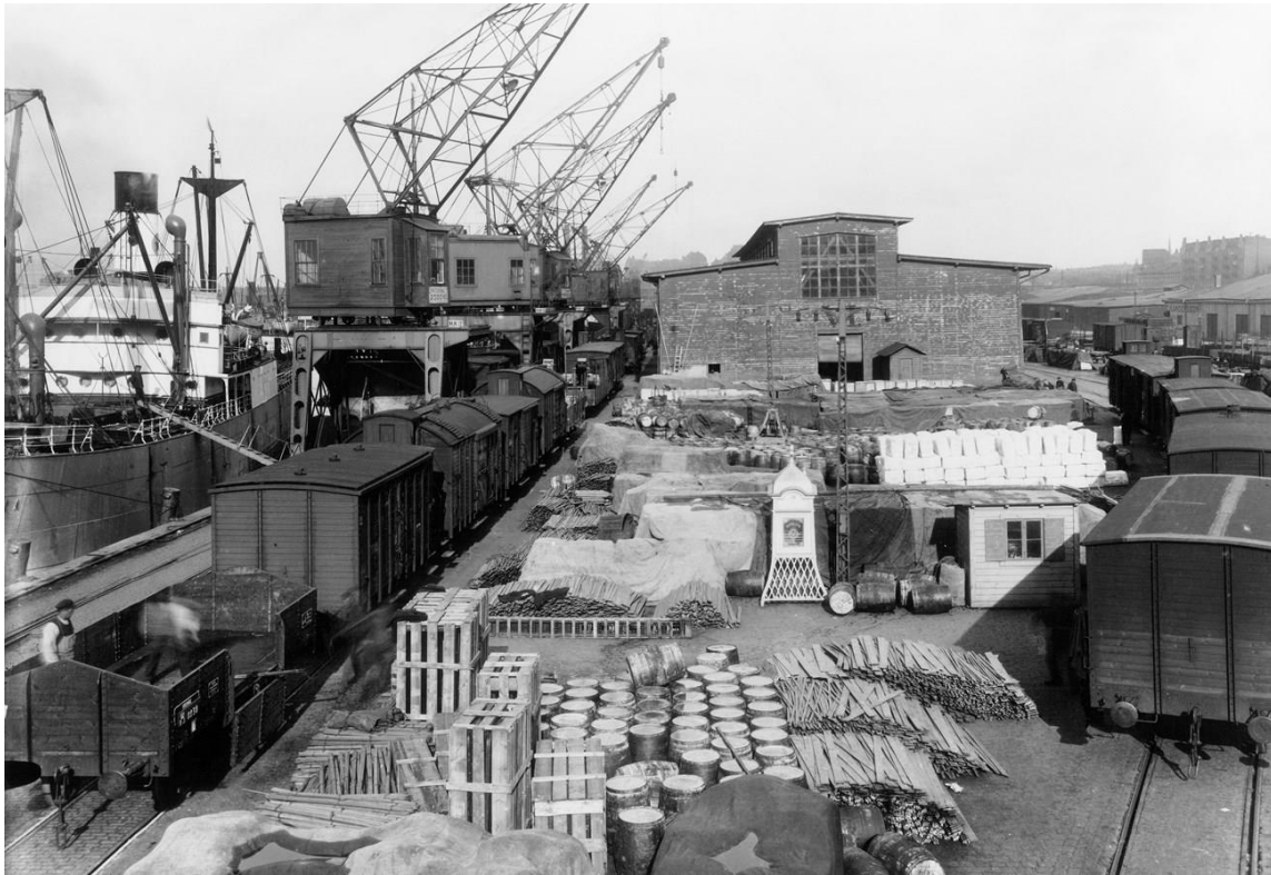
Masthuggskajen 1920-tal. Kranarna ser ut att var i samma generation som kran 50 och 89. Kranjibbens konstruktion är densamma som på kran 50. Foto: www.goteborgshamn.se img 001
