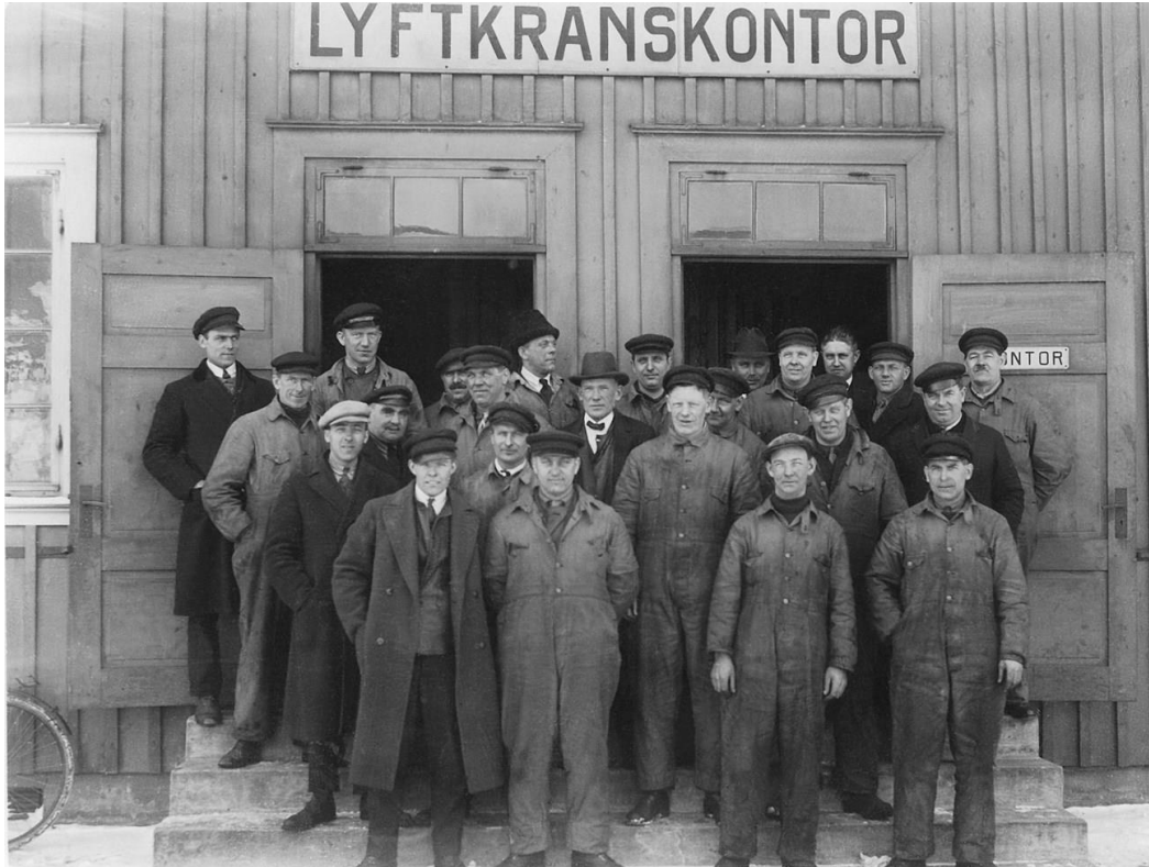
Lyftkranskontor Masthuggskajen. 1930-tal. Kan ett liknande kontor ha funnits på Gullbergskajen? Foto www.goteborgshamn.se
