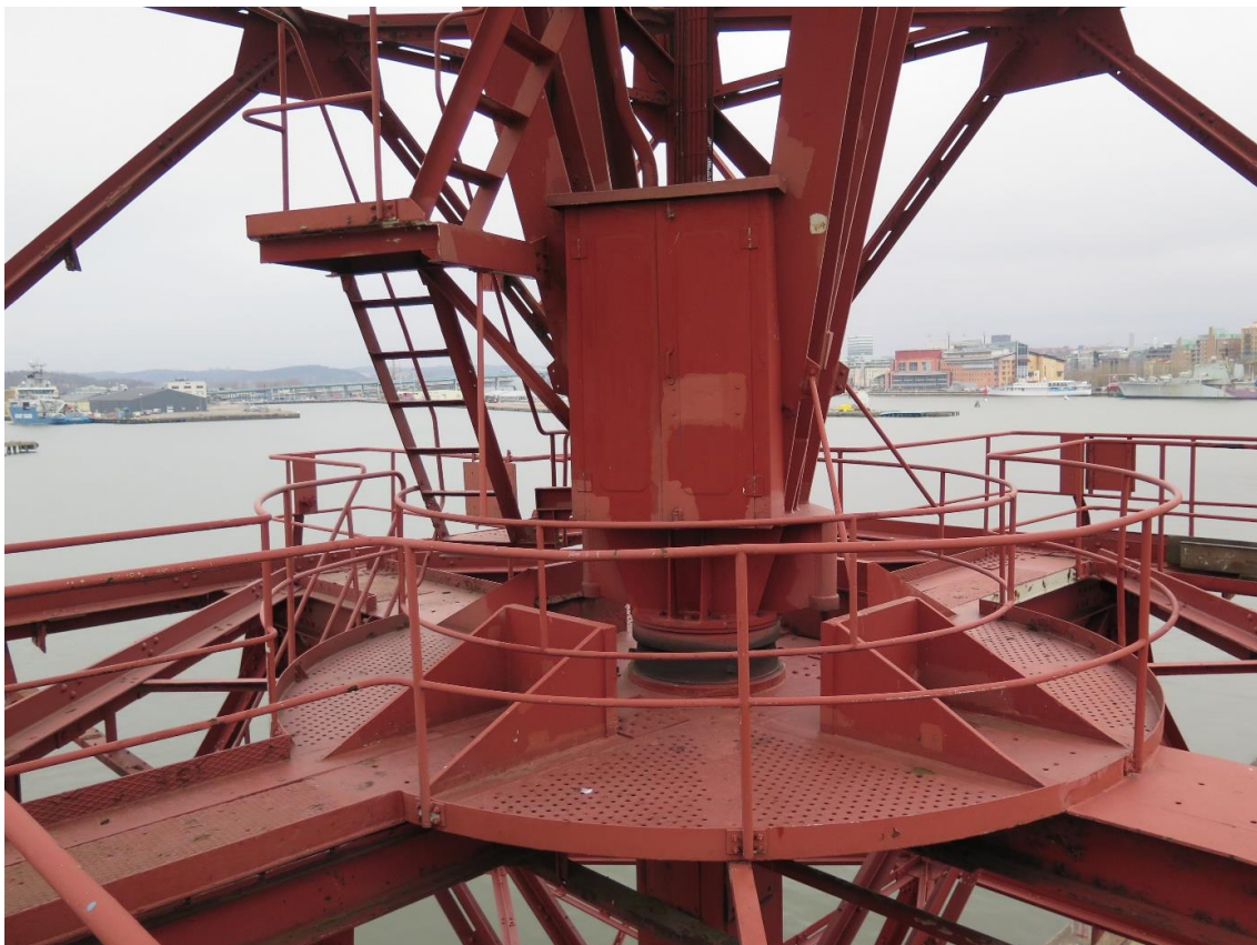
Konstruktionen kring lagret för den rörliga svängskivan med förarhytt, maskinrum och kranjibb.
