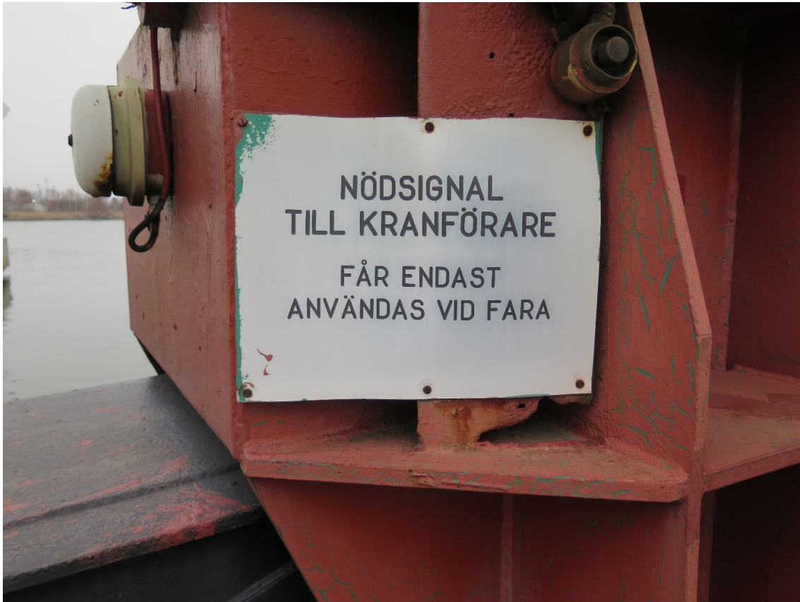
Informativ skylt för allas säkerhet. Knappen till nödsignalen syns uppe till höger i bild.
