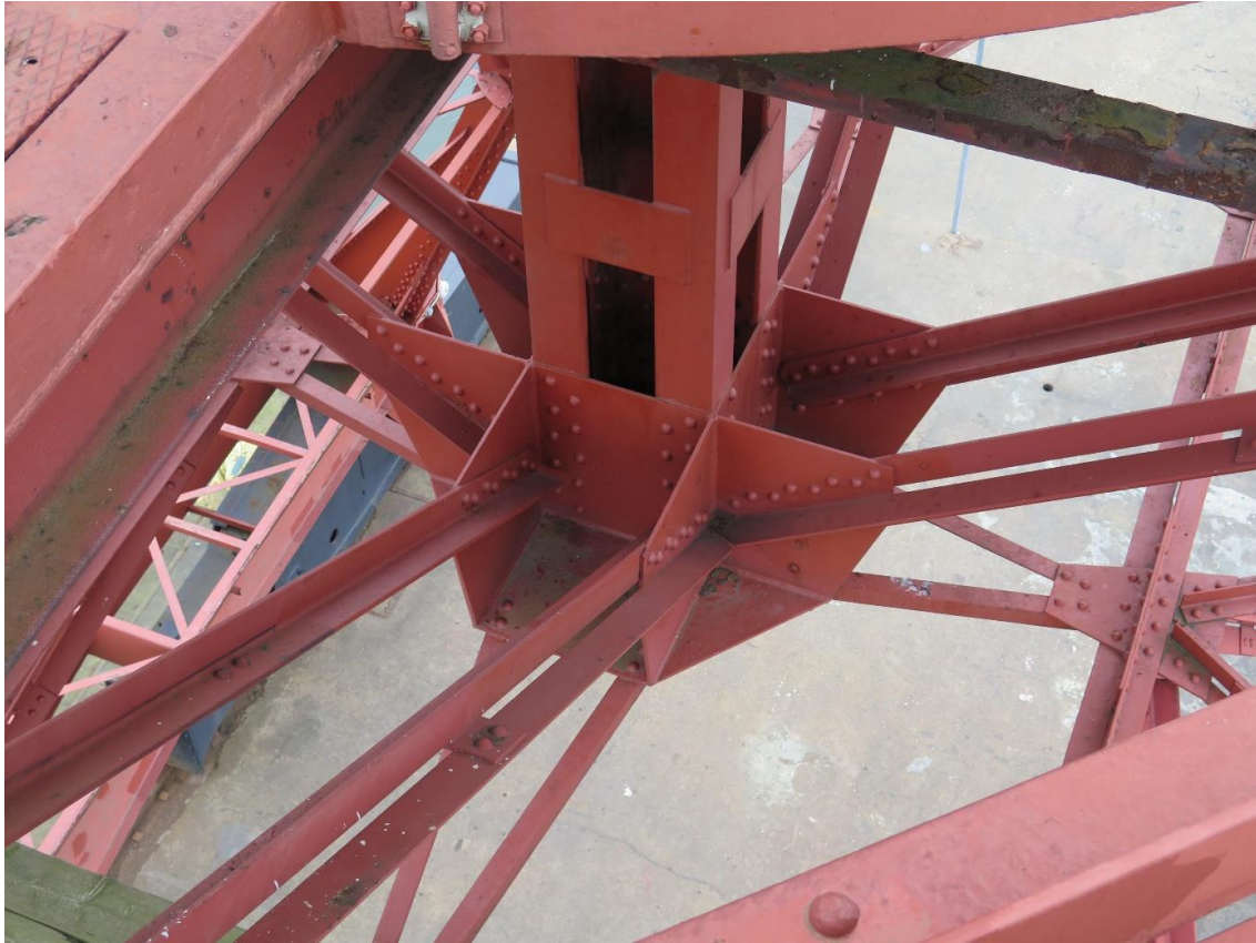
Konstruktionen under lagret som ses nedan.
