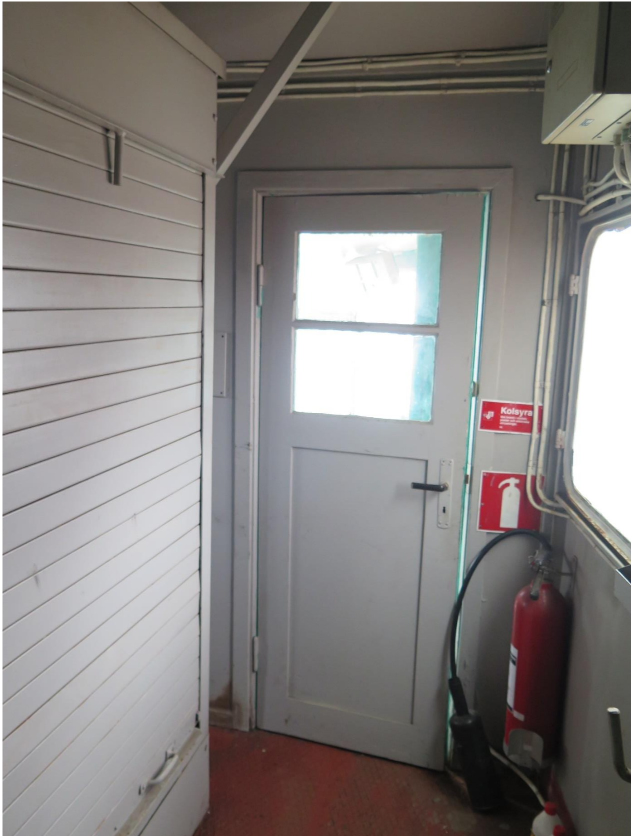
Väggen och dörren mellan maskinrummet och förarhytten är byggda i trä.
