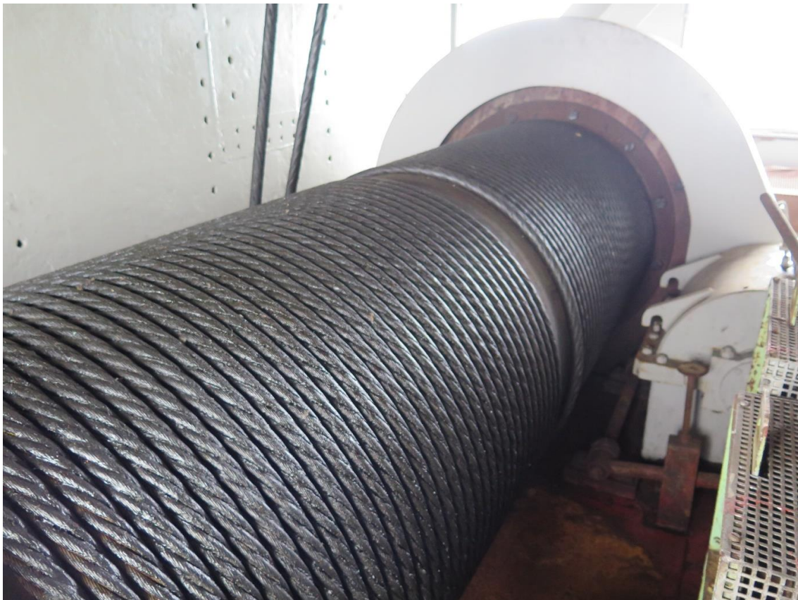
Vajertrumman för stora kroken. Lyften fördelas mellan två linor. Totalt lyfter kranen 40 ton.
