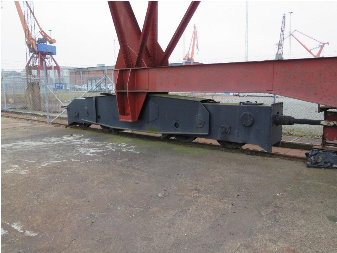
Östra boggin i södra portalbenet. I bakgrunden syns kran 10.
