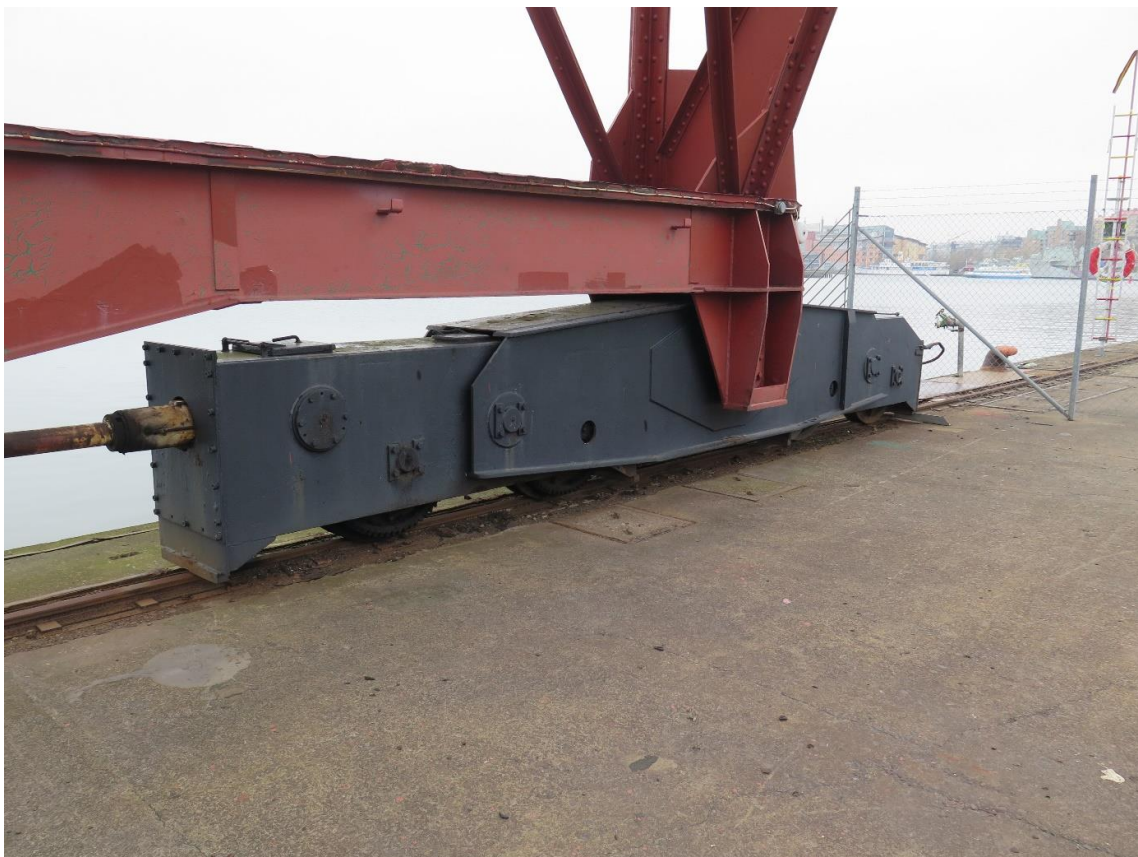
Östra boggin i norra portalbenet. Foto i riktning mot centrala Göteborg.
