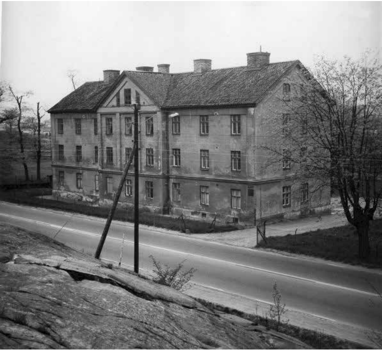
Göteborgs hospital i Gamlestan. Byggnaden rivs 1963.
