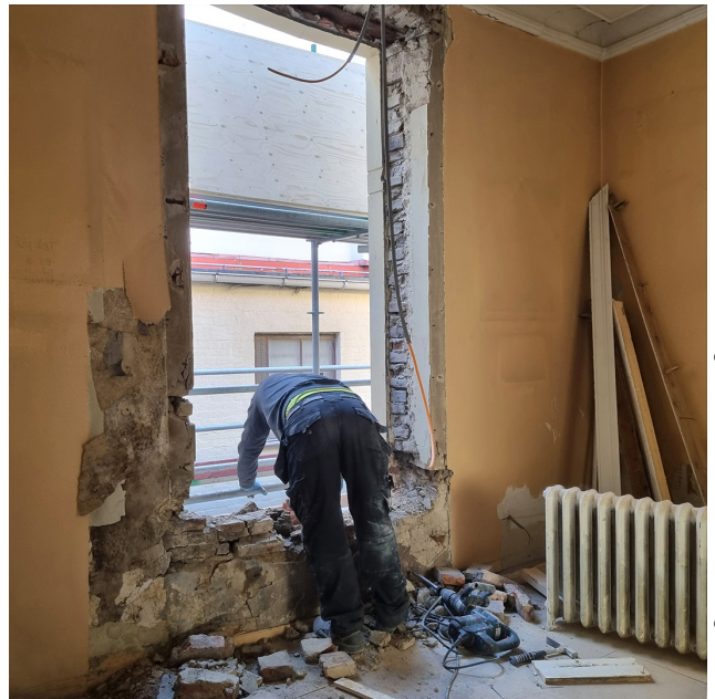
Oredahlska huset under renoveringen 2022. Foto: Annika Engström
