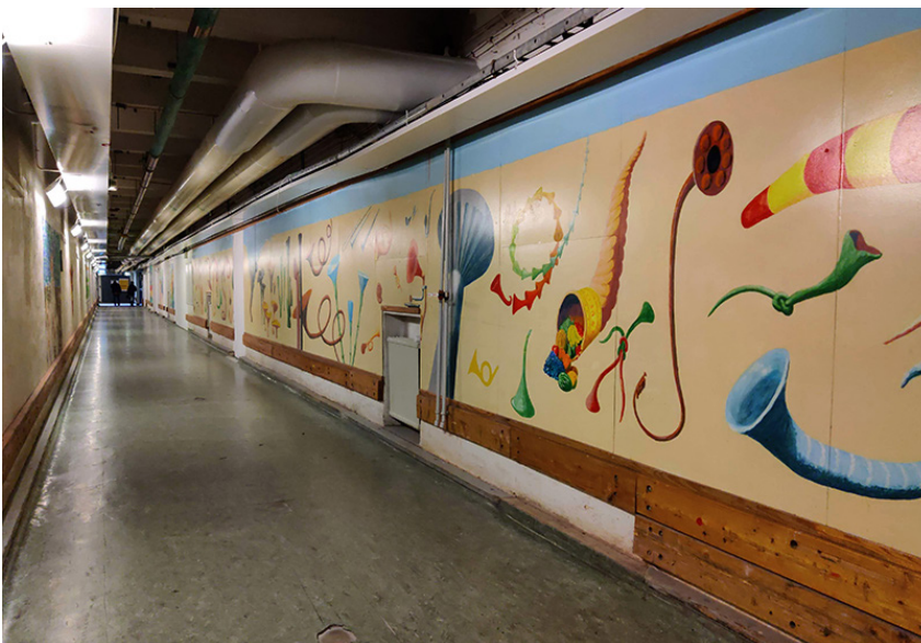
Kulvertarna under Lillhagen. Foto: Annika Engström 2021.
