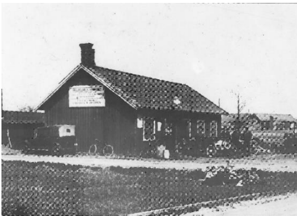
Regnströms verkstad vid väggorsningen Nämndemansvägen/ Tingshusgatan. Fram till 2020 var ett av Varas äldsta företag aktiv här. Verksamheten hade bedrivits i över 100 år, först som smedja och sedan som verkstad. Bildkälla: Vara hembygdsförening.
