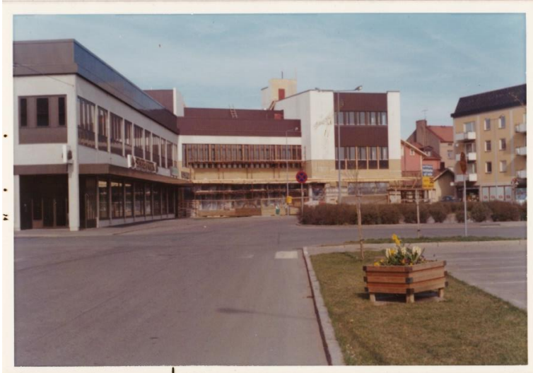
Sedan några år tillbaka ligger Coop i den del av fastighet som byggdes 1973 för ICA:s livsmedelshall. Däremellan var hallen en Netto-butik. Bildkälla: Vara hembygdsförening.
