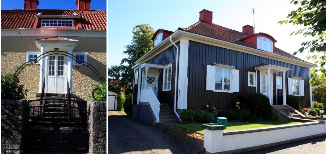
Bild t.v. Entréparti Snäppan 5 . Bild t.h. Snäppan 4 .
