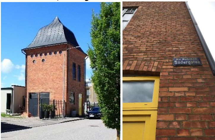
Transformatorstation, är sedan 2007 q i detaljplan.
