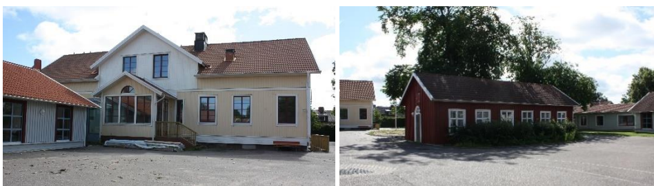
Bild t.v. Skolbyggnad uppförd under 1800-talet, idag mycket förändrad. Bild t.h. Äldre byggnad troligen samtida med skolbyggnad. Byggnaden omges idag främst av yngre byggnadskroppar.
