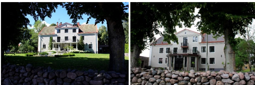
Pionen 2, t.v. Sett från Odengatan, t.h. byggnaden sett från Kungsgatan.
