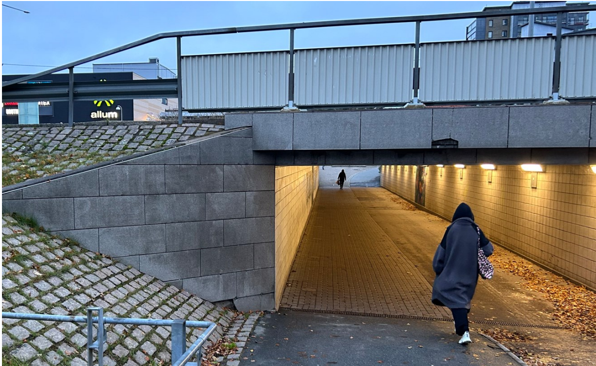
Figur 53 Partille C befintlig gångtunnel
