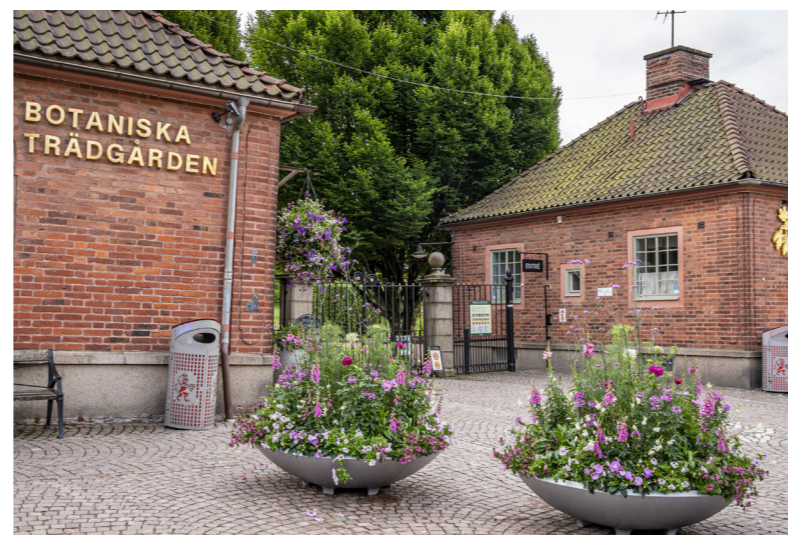
5701/5702 Norra och Södra Porthusen
