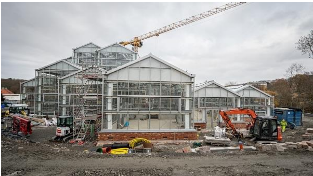
Foto från projekt Nya växthus och besökscentrum, november 2025.
