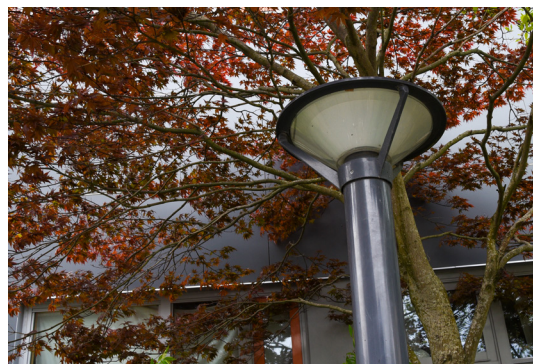
Belysning i buskage är till för att skapa trygghet och samtidigt lysa upp våra utemiljöer.
