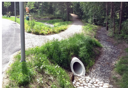
Vattenanläggning som hanterar dagvatten vid regn. Det är ett exempel på en multifunktionell yta som både har en teknisk och estetisk funktion.
