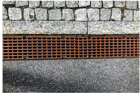
Brunnar finns i olika former och funktioner. Här är en linjeavvattning med galler som beteckning.
