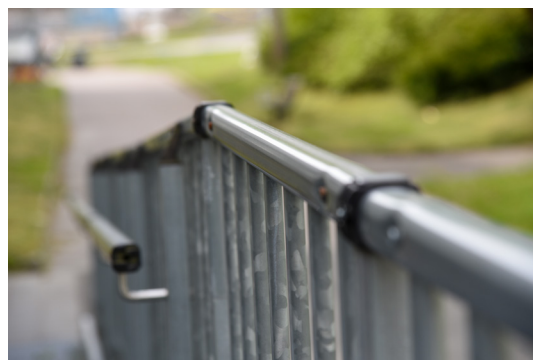
Räcken och handledare är bra för dem som behöver ett extra stöd i trappor och ramper. Det är också ett lagkrav för tillgänglighet.
