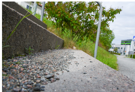
Kvarlämnad halkbekämpning som ska tas bort i samband med vårstädningen.
